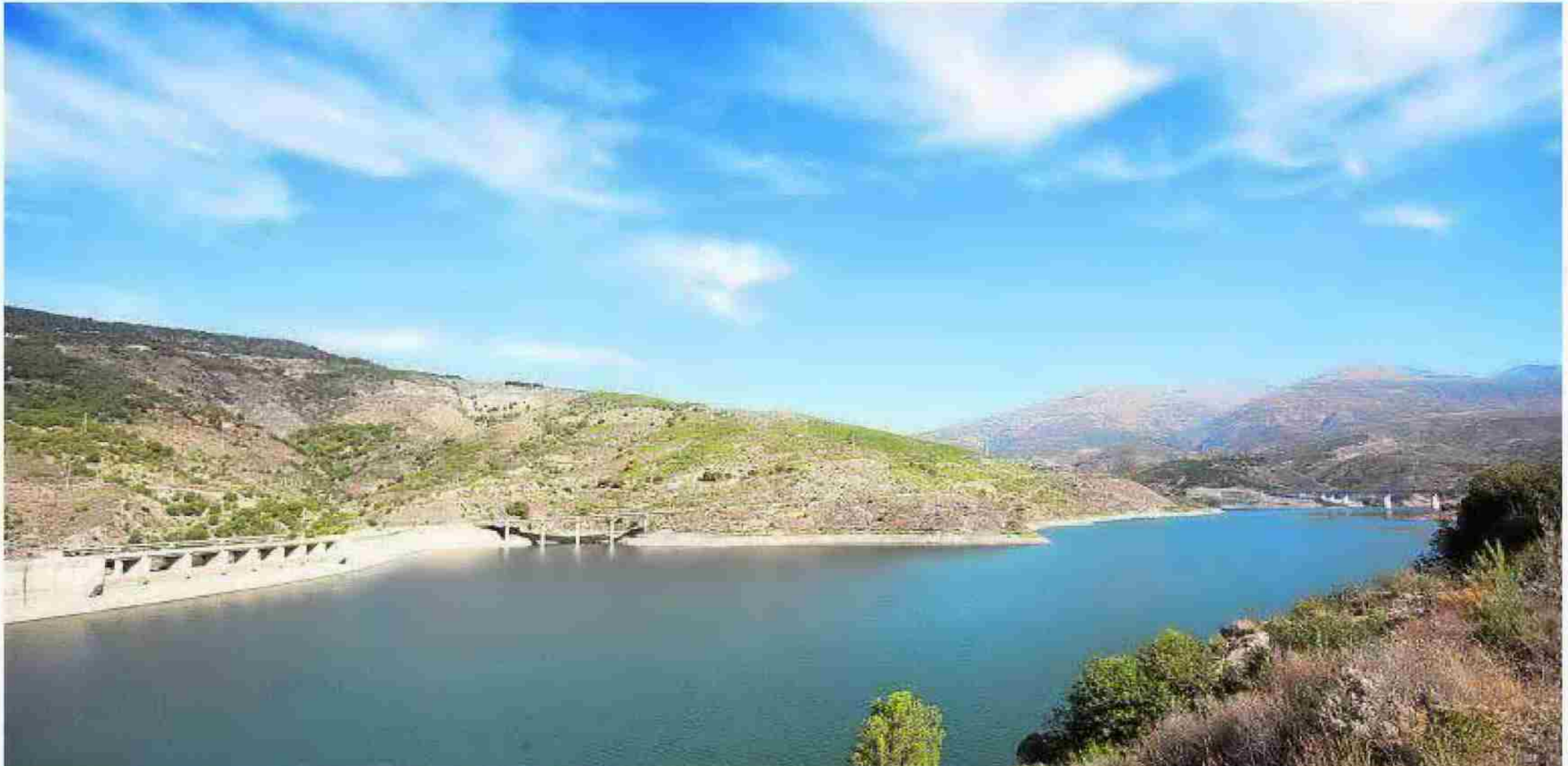
Vista de la presa de Rules, cuyas reivindicaciones en la Costa para canalizar sus aguas llevan ya más de una década. :: JAVIER MARTÍN
