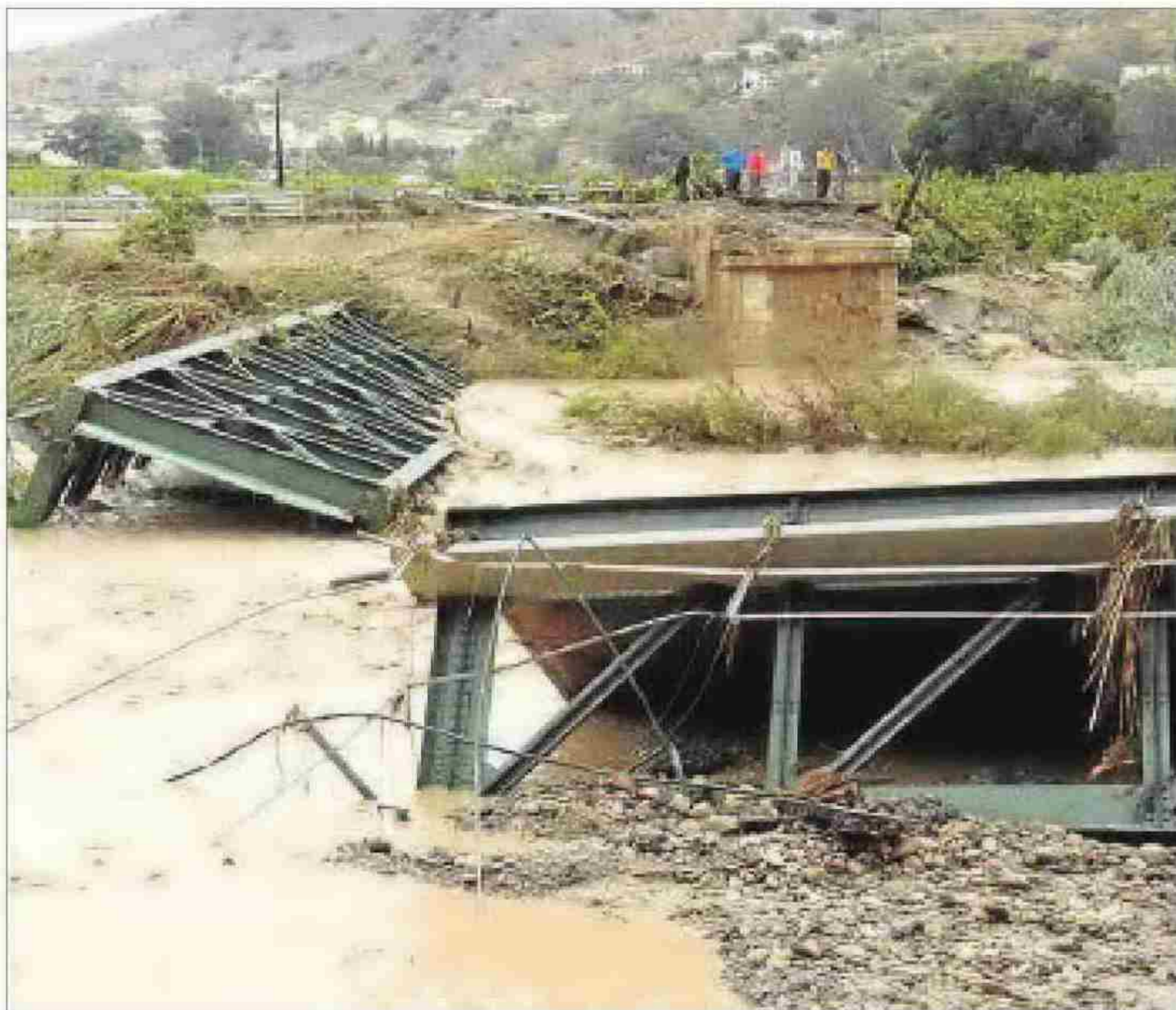
A la izquierda, imagen de cómo quedó el puente de hierro de Álora, tras la riada de 2012, y a la derecha, imagen del estado actual del cauce del río. L. O.
