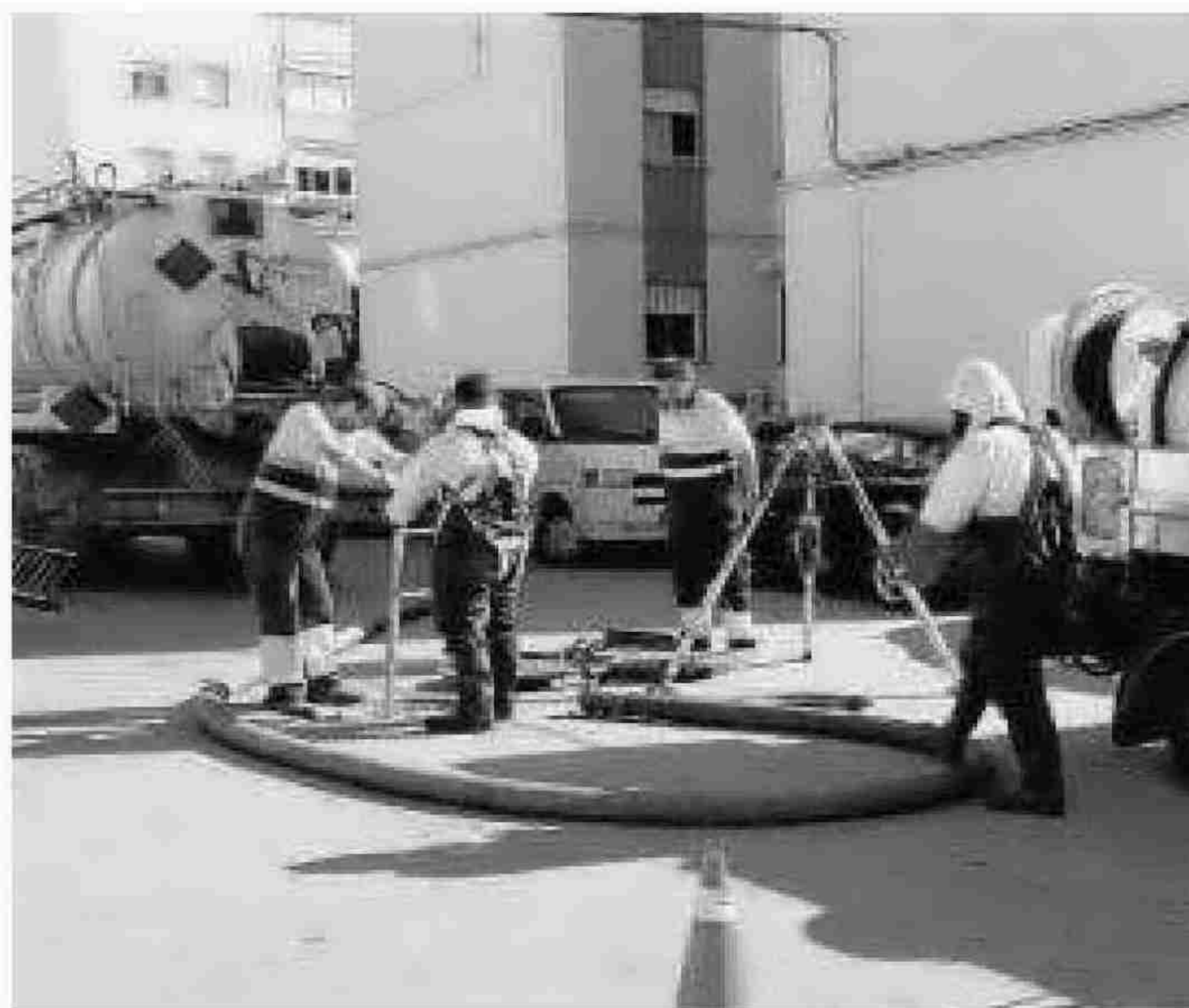
Trabajos de limpieza del alcantarillado que comenzaron ayer.
