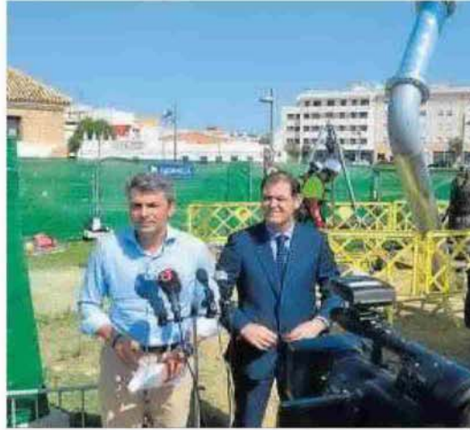
Romero (l.), ayer en el Zaporito, ante las obras en la estación de bombeo.
