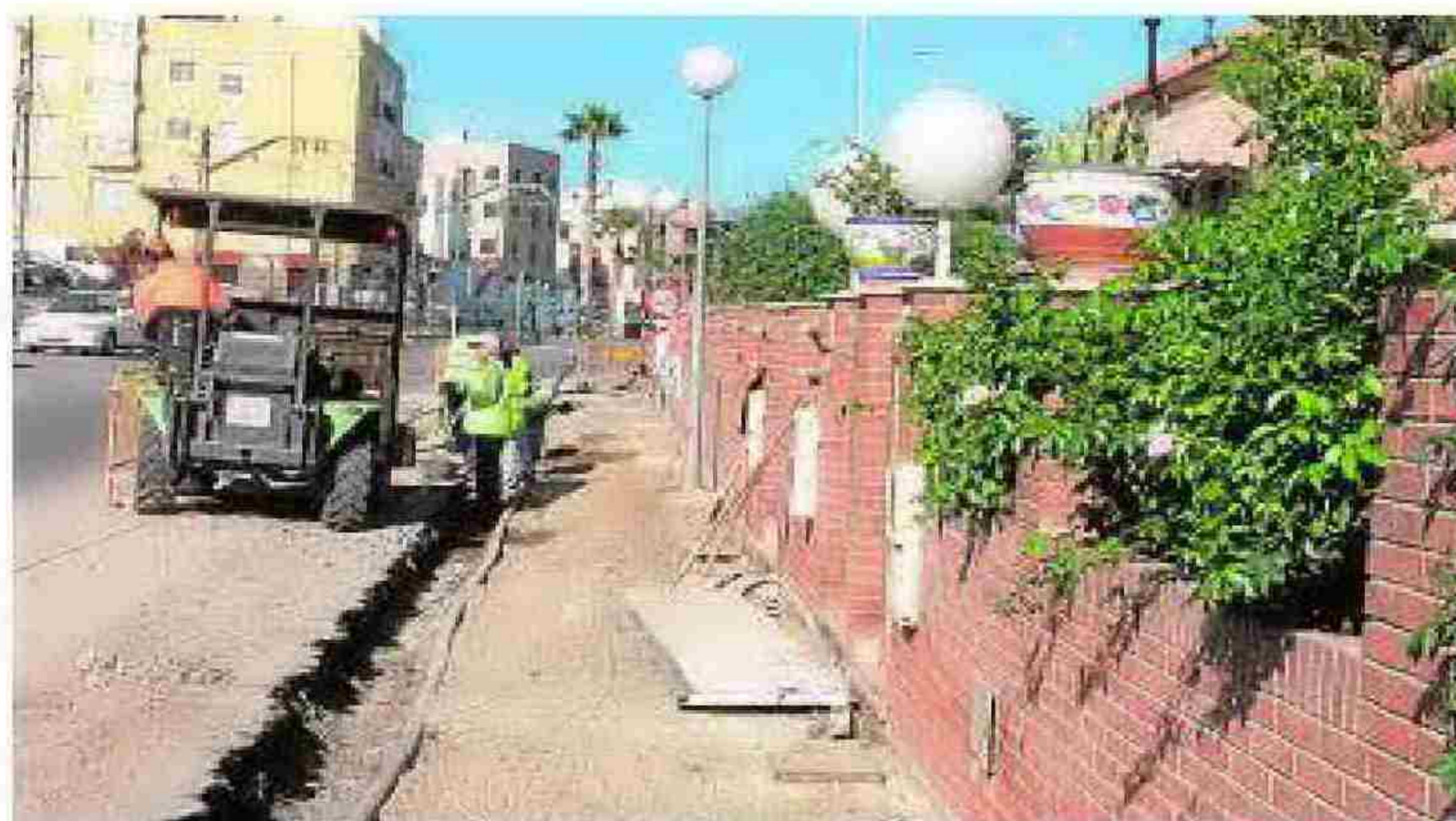
Algunos de los trabajos que se están llevando a cabo. :: IDEAL
