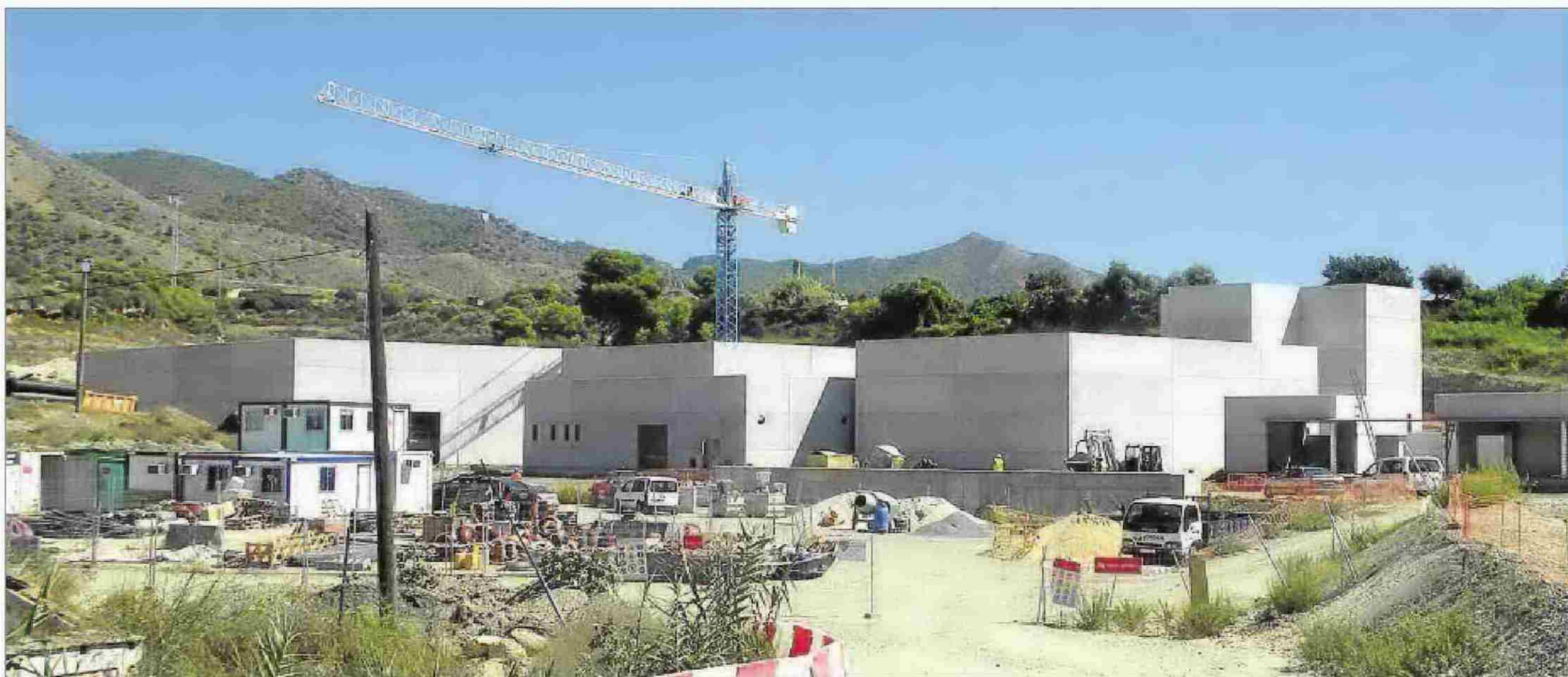
Estado que presentaban ayer las obras de la primera estación depuradora de aguas residuales que albergará Nerja. F. E.
