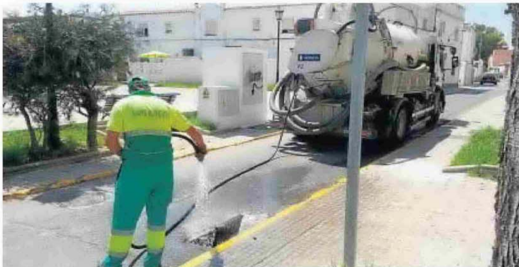
Un operario de la concesionaria, trabajando en la campaña de limpieza de la red de alcantarillado.
