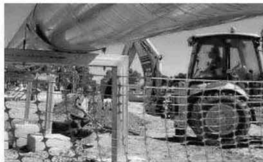
Obras en la depuradora en agosto, tras el acuerdo entre Junta y empresa.
