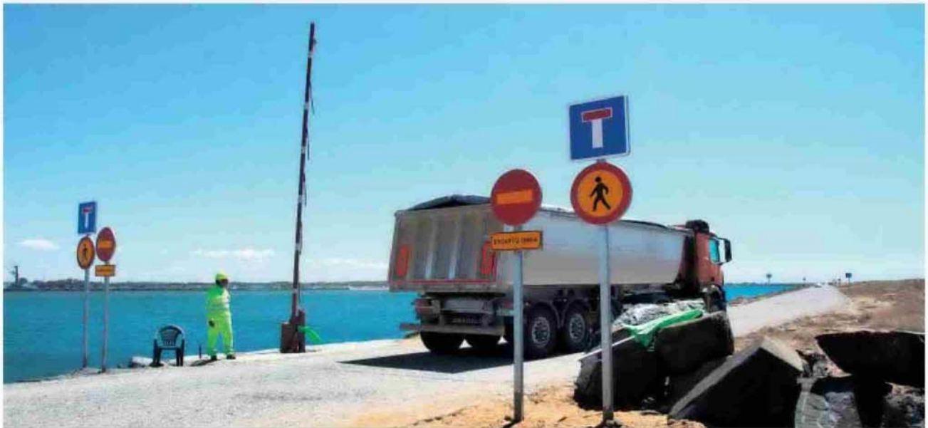
La empresa Sato construye una balsa de 1,2 kilómetros de superficie en el lado derecho del dique Juan Carlos I, licitada en abril por la Autoridad Portuaria por 13 millones de euros.
