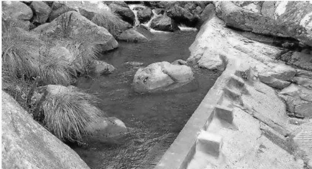
Imagen de archivo de la presa con la que se capta el agua en la Garganta del Capitán.
