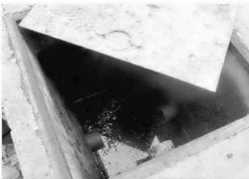
Uno de las arquetas donde se depositaban los vertidos.
