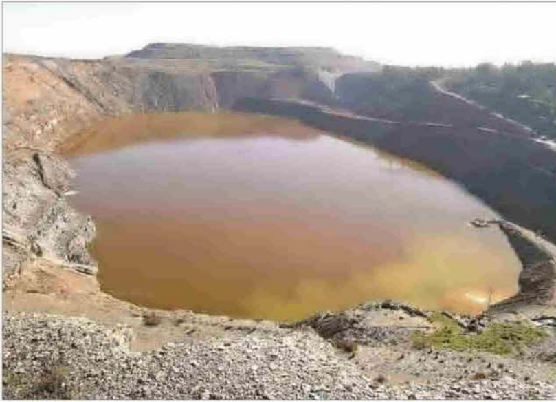
Aspecto de la balsa de aguas ácidas de la mina de Aznalcóllar, cerrada tras el desastre de 1998. EL MUNDO
