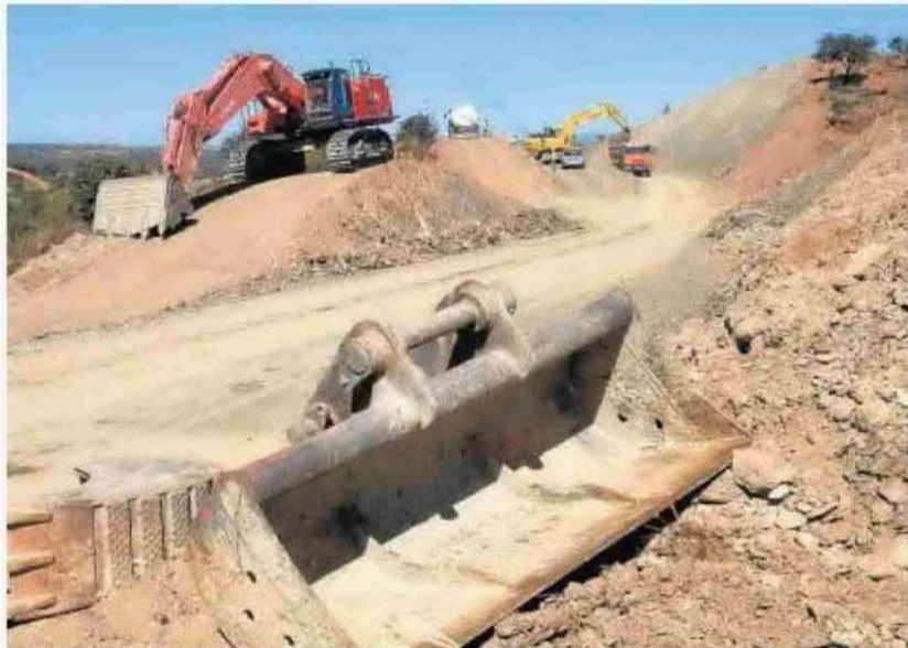
Obras de construcción de la Presa de Alcolea.
