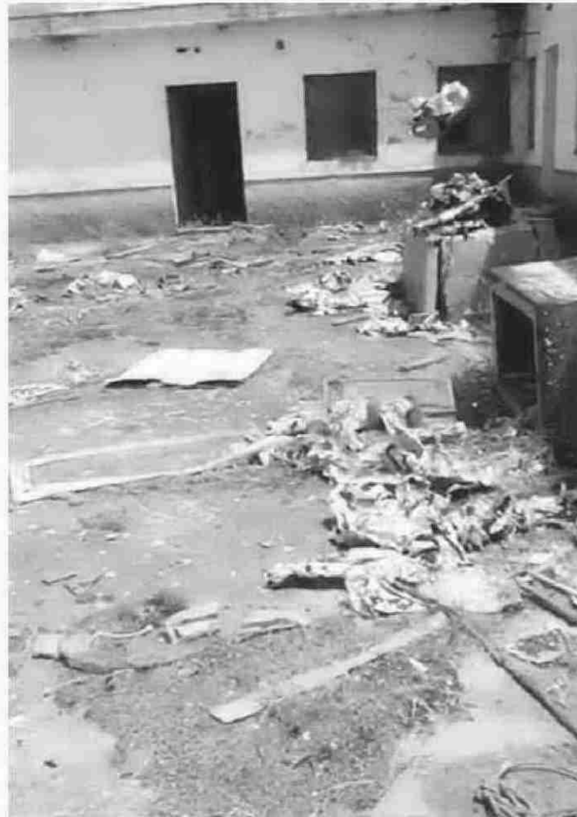
CUARTEL-VERTEADERO. Ecologistas en Acción ha criticado el estado de “abandono” en el que se encuentra el cuartel de Malandar -antiguo cuartel de la Guardia Civil a esos metros de la desembocadura del Guadalquivir-, que se usa como si “fuera un contenedor”. VH
