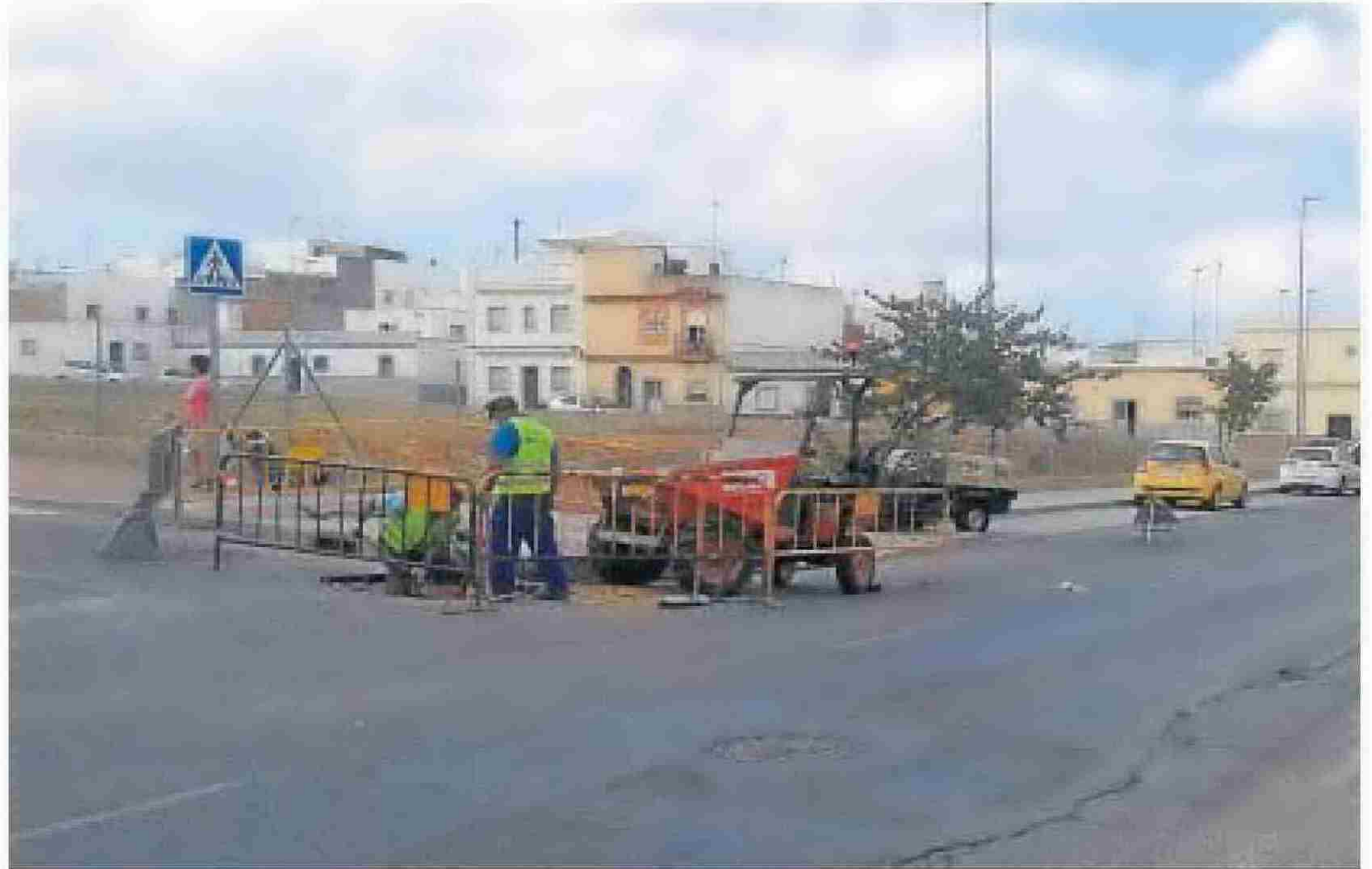
Trabajos que se están llevando a cabo en la zona de La Fuensanta.
