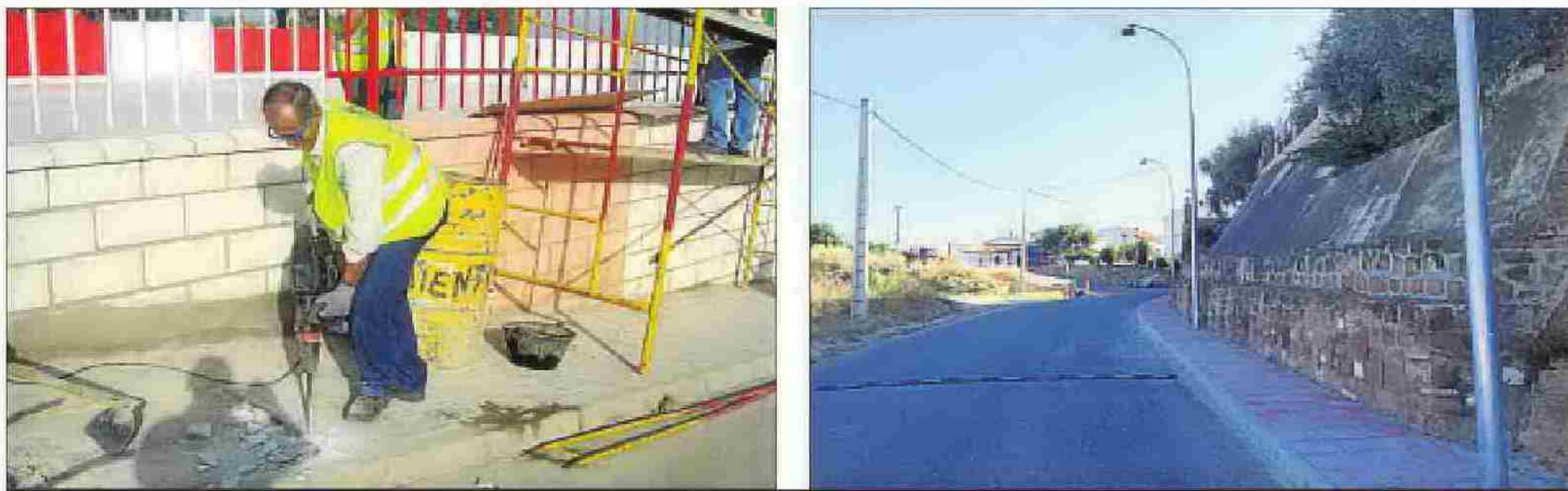
Dos de las actuaciones realizadas en espacios urbanos de Montoro, que se han revitalizado con estos trabajos del Profea.
