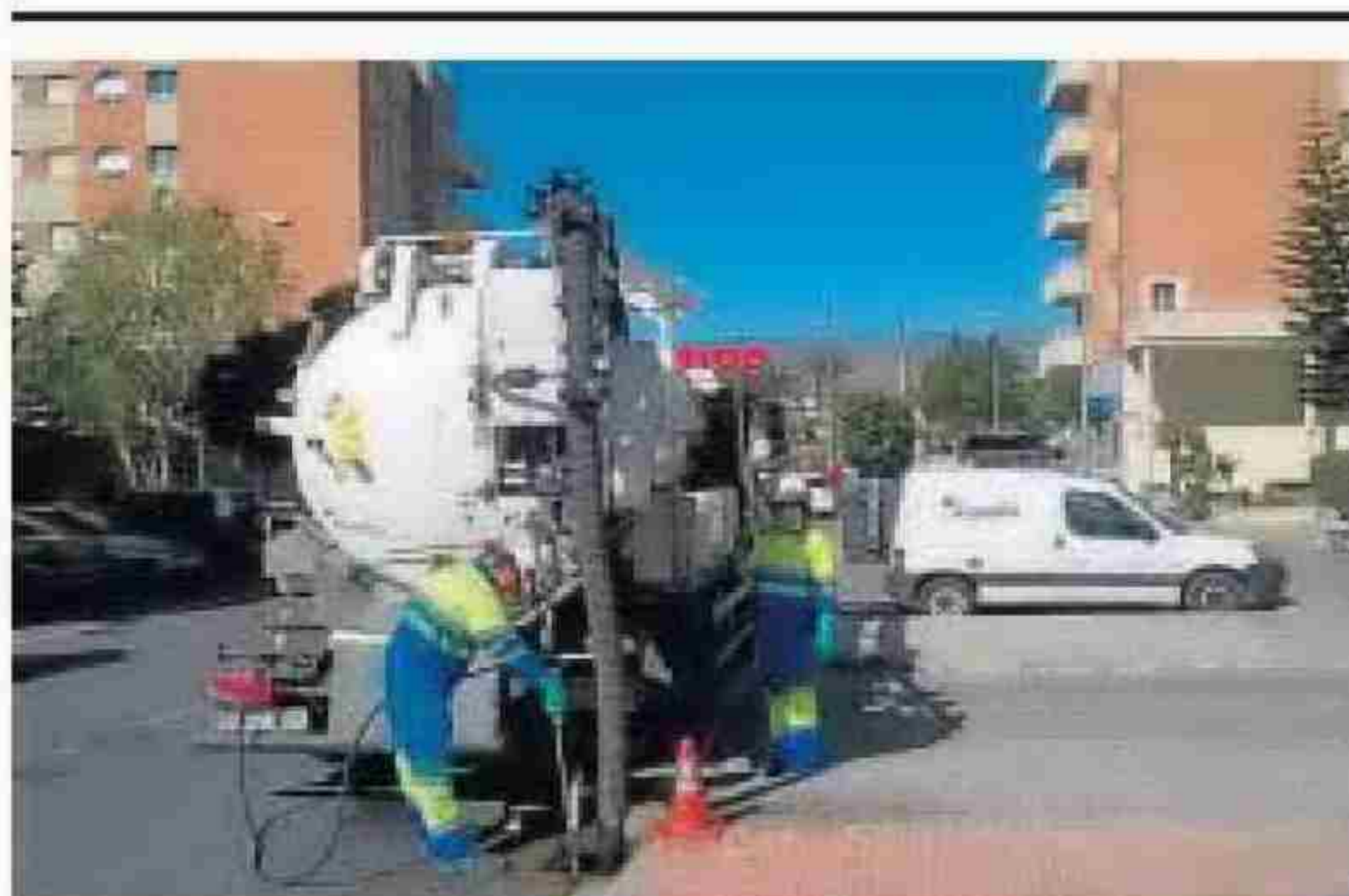
Operarios de Aqualia durante la limpieza de imbornales.
