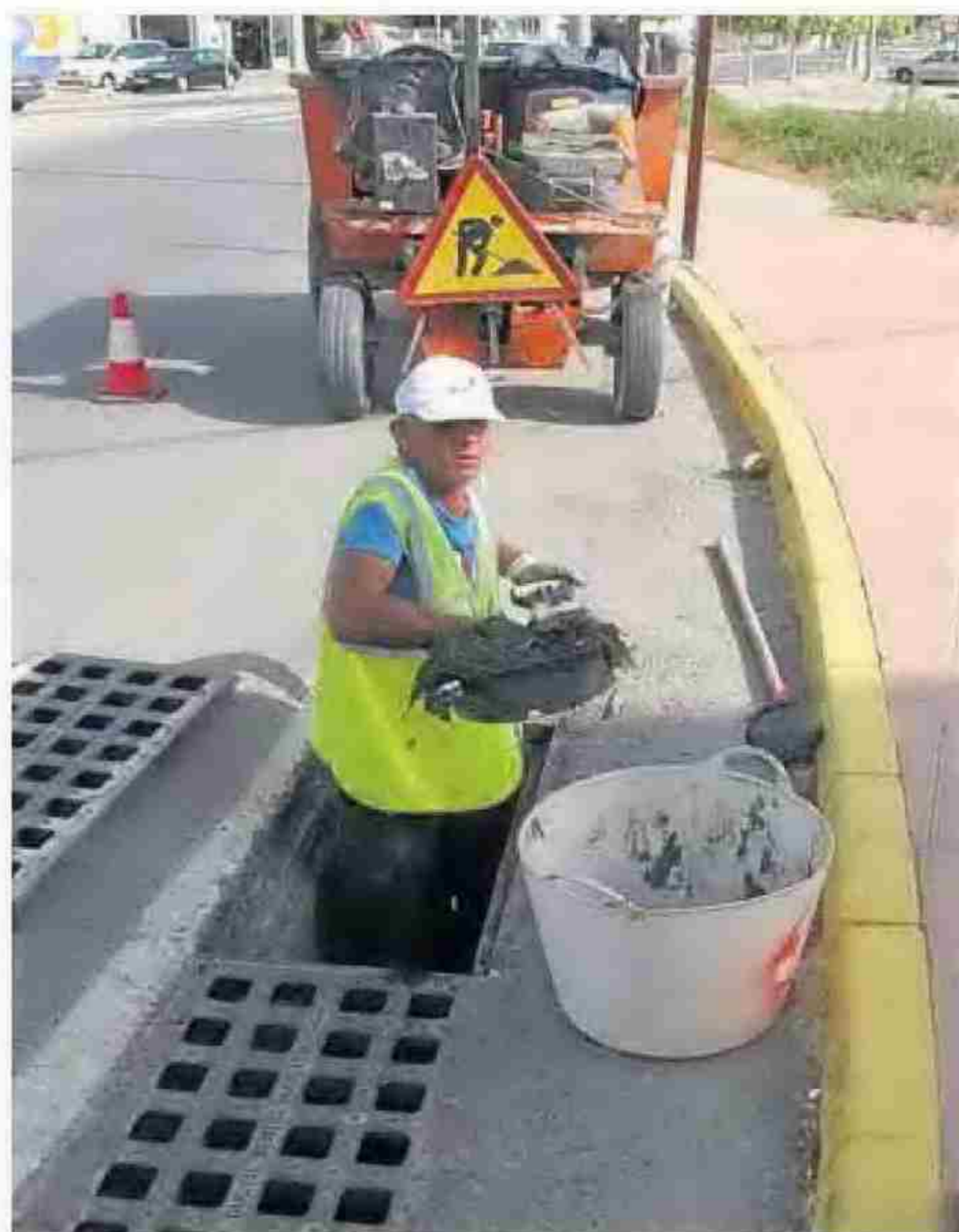
UN OPERARIO limpia los imbornales en Vera. LA VOZ
