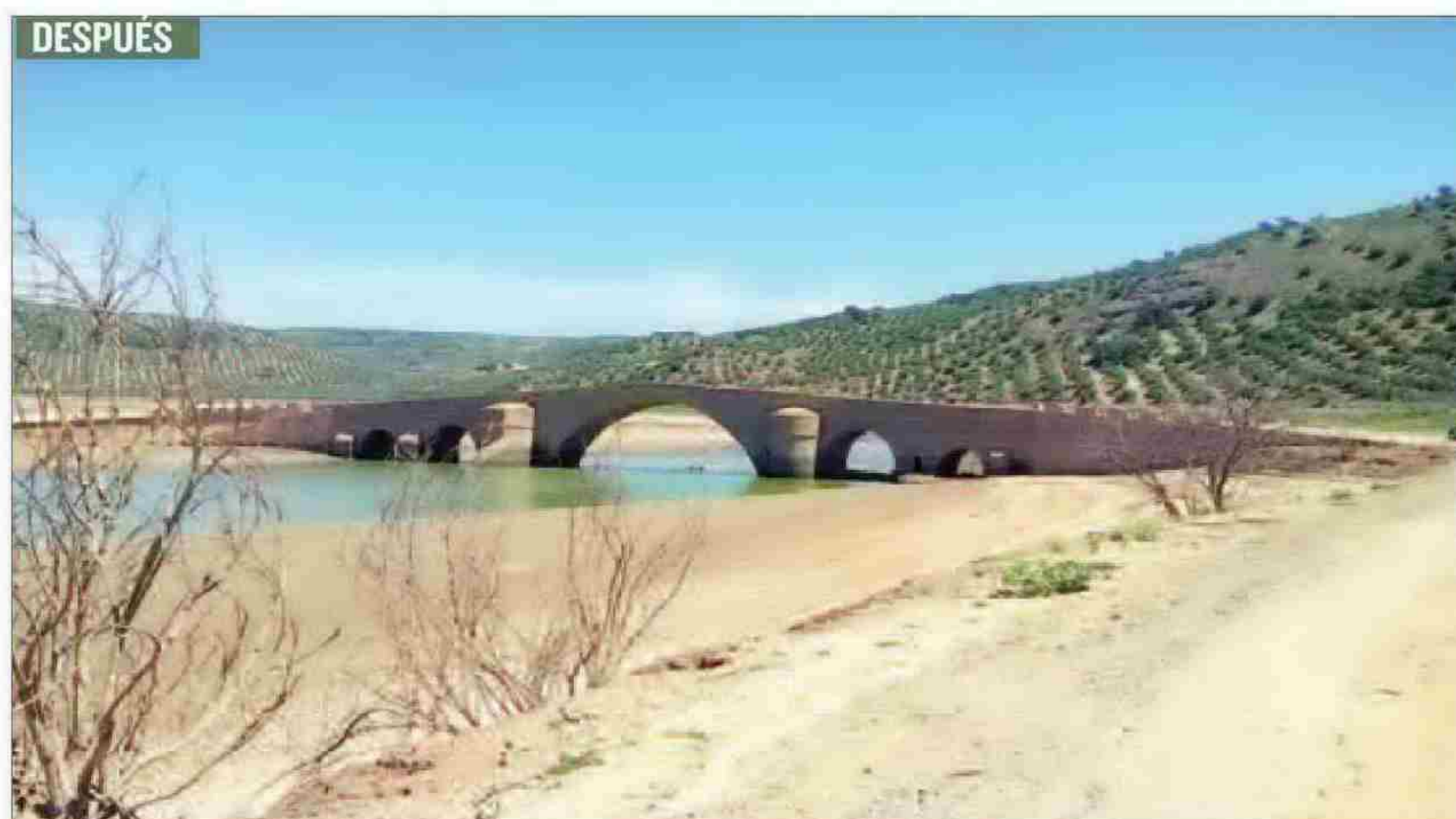
PUENTE. Arriba la obra se encuentra sumergida sobre las aguas; sobre estas líneas, en la época estival de sequía.
