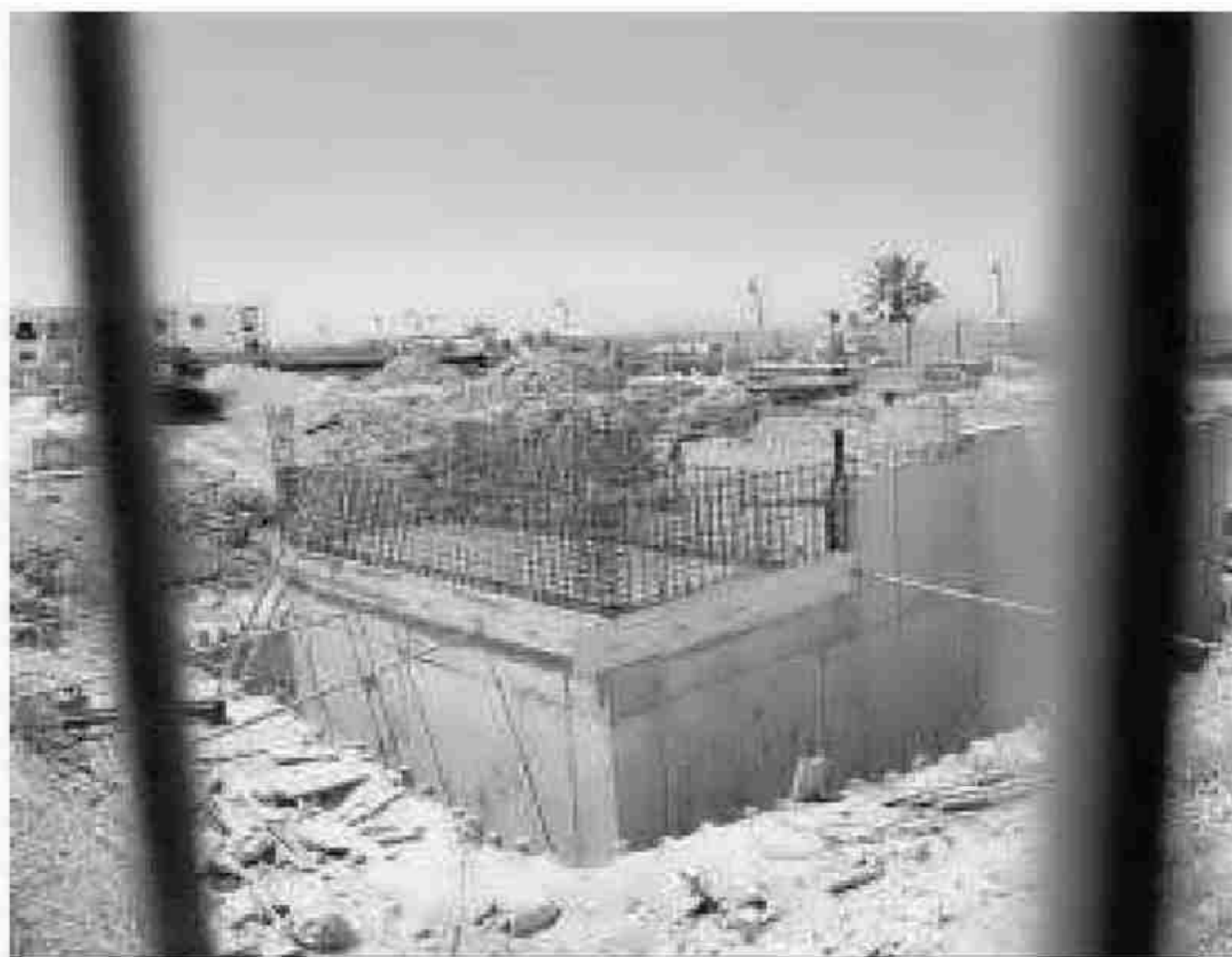
Imagen de una de las instalaciones hormigonadas.
