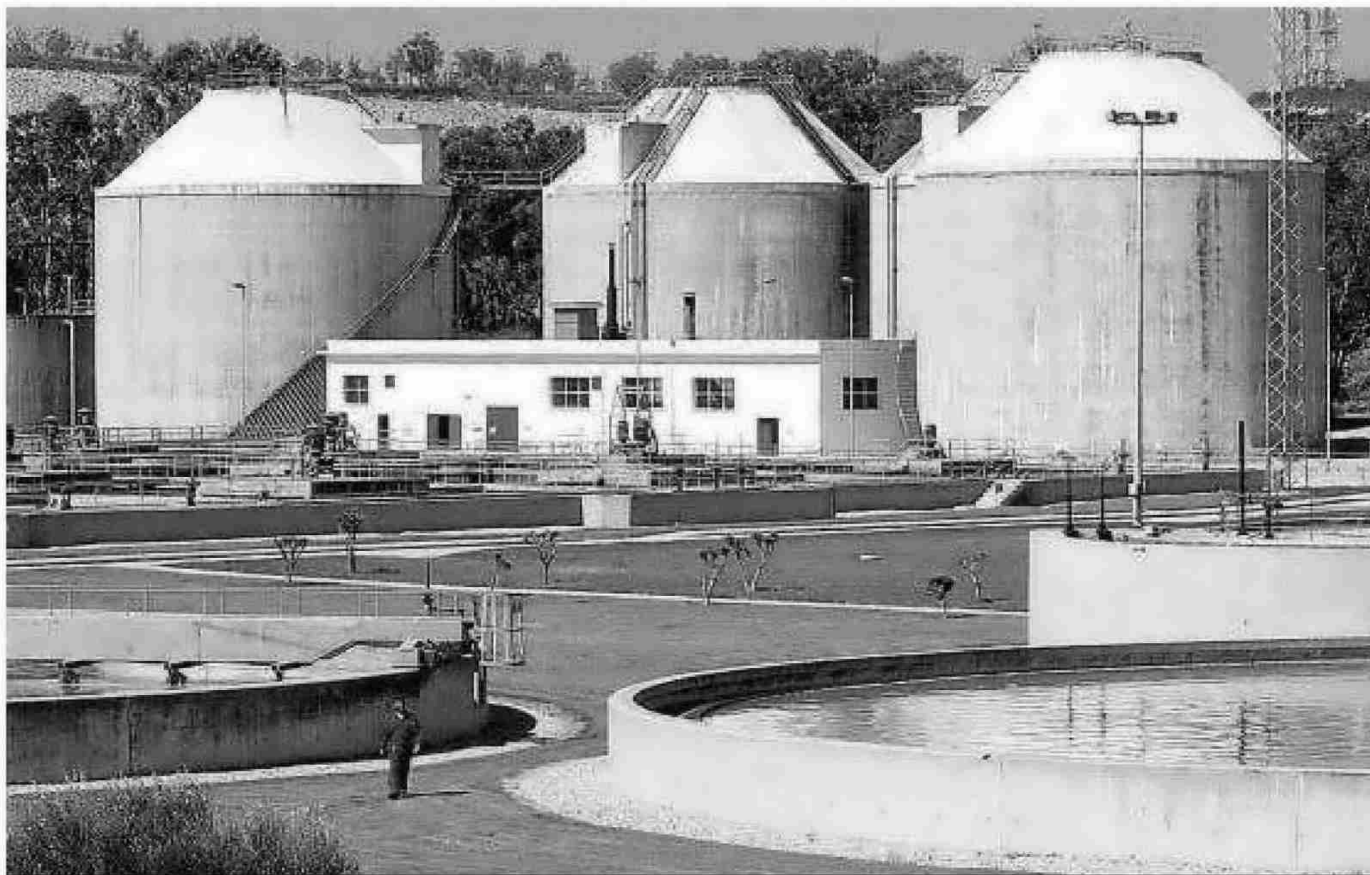
Estación depuradora del río Guadalete, en Jerez.
