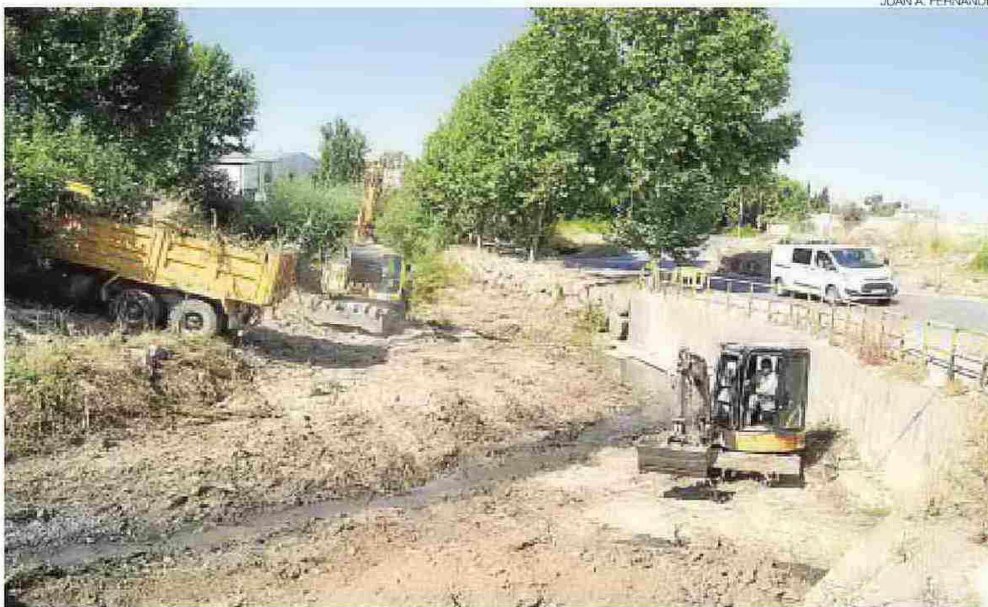
►► Trabajos de limpieza del río Lucena que se realizan a la altura de la zona del Cascajar.
