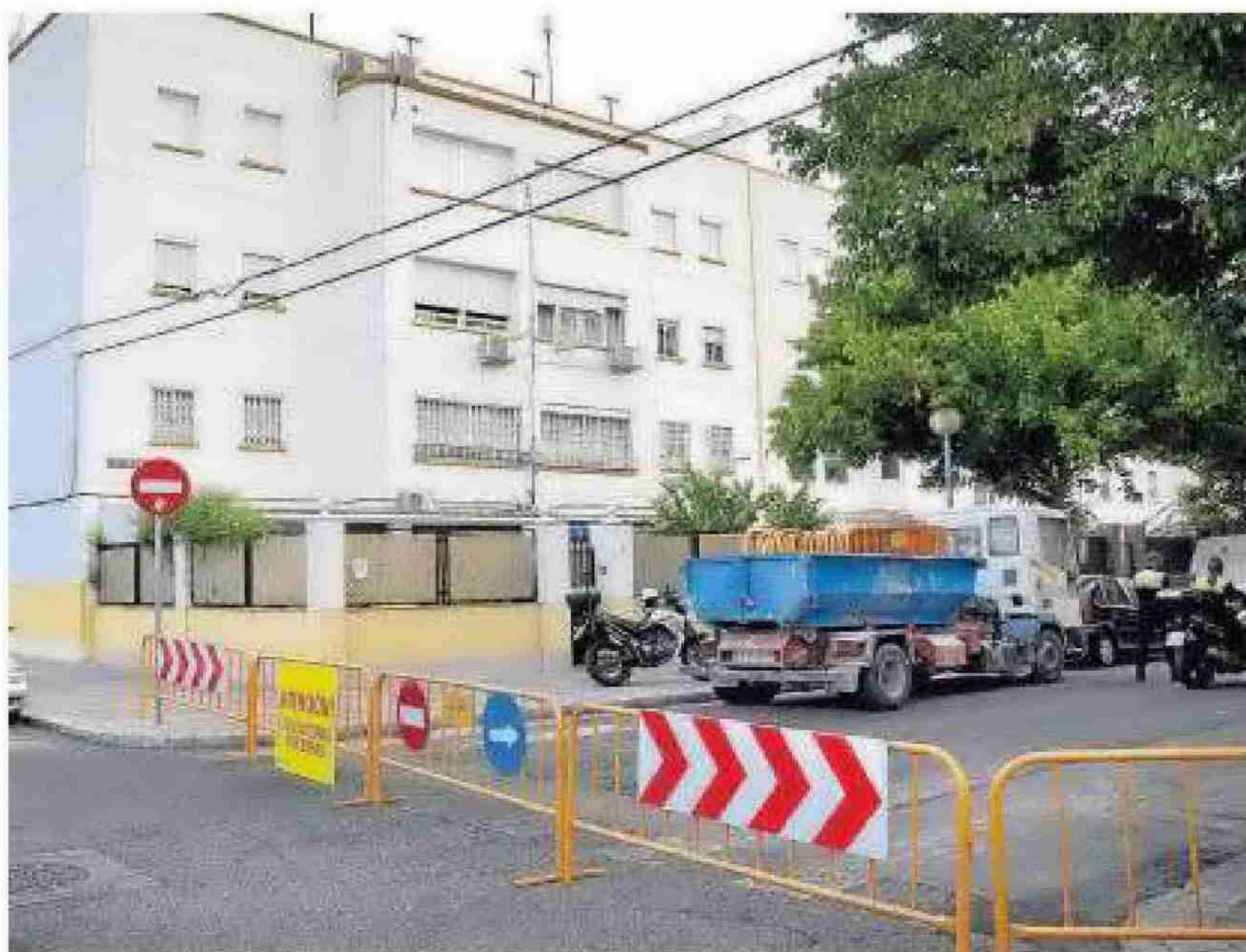
Una calle de La Plata cerrada al tráfico ayer para el inicio de la obra.
