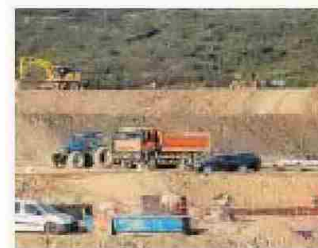
Obras en la presa Alcolea.
