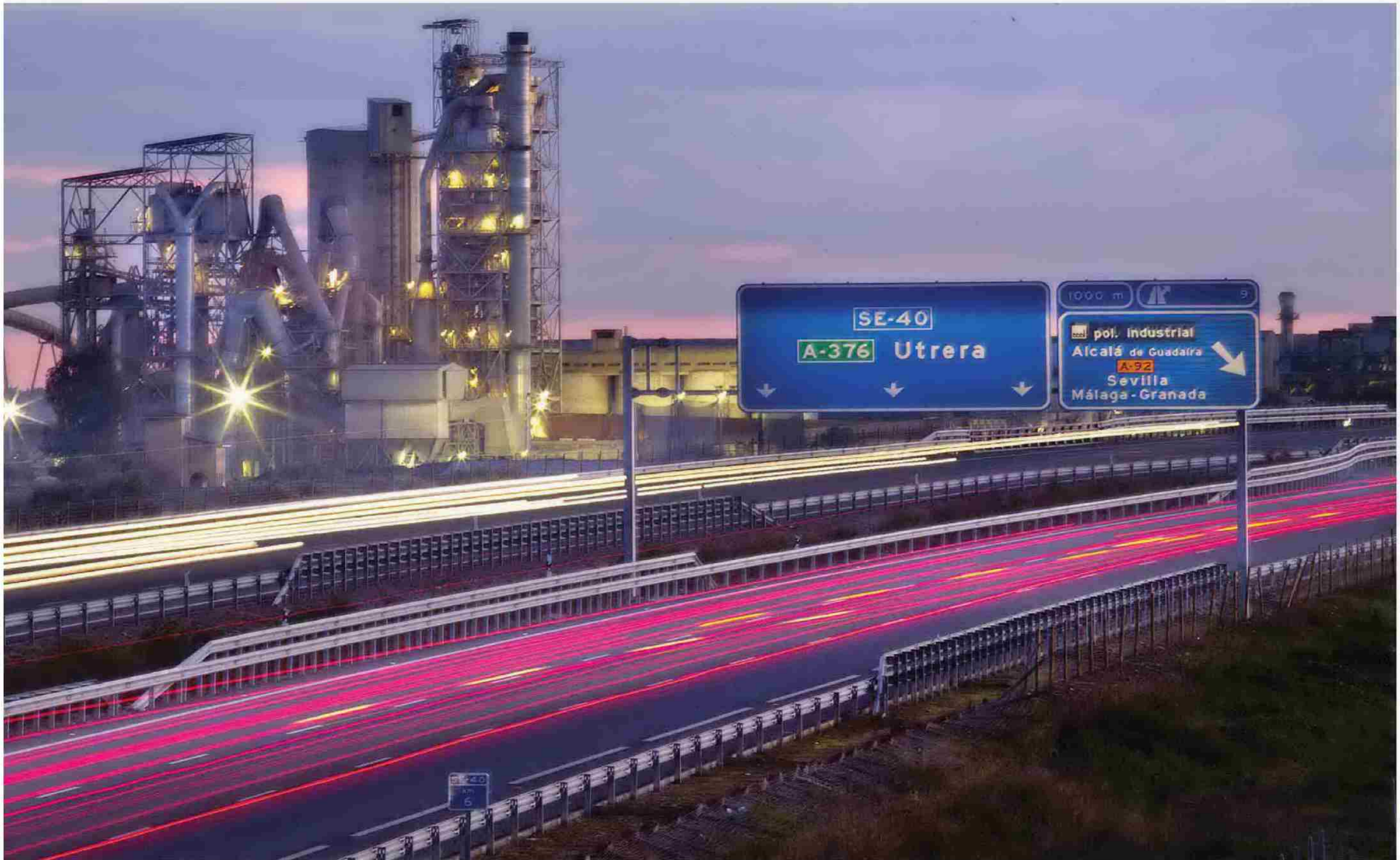
circunvalación de la SE-40 a la altura del enlace con la A-92 y el entorno de polígonos industriales de Alcalá de Guadaíra. /Pepo Herrera
