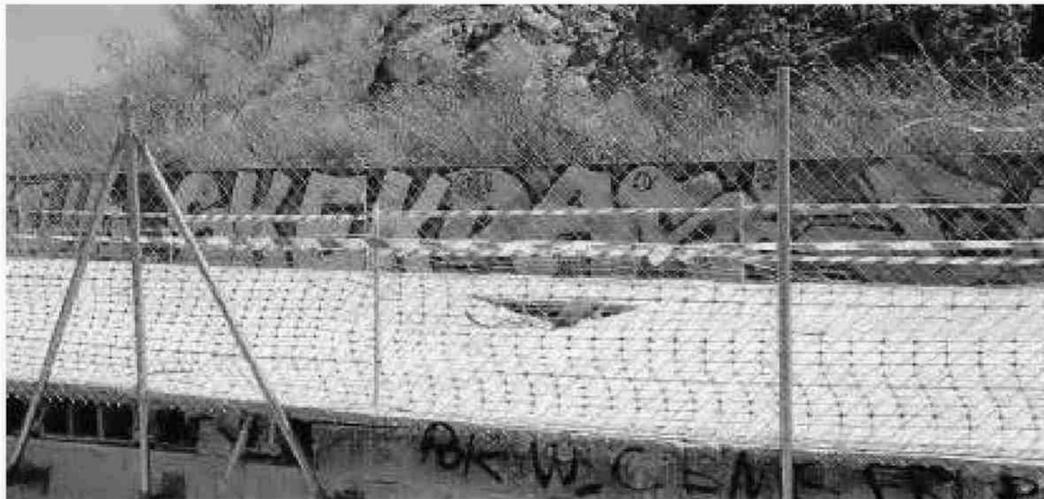
Tramo del canal de abastecimiento vallado por el hundimiento de la cubierta.
