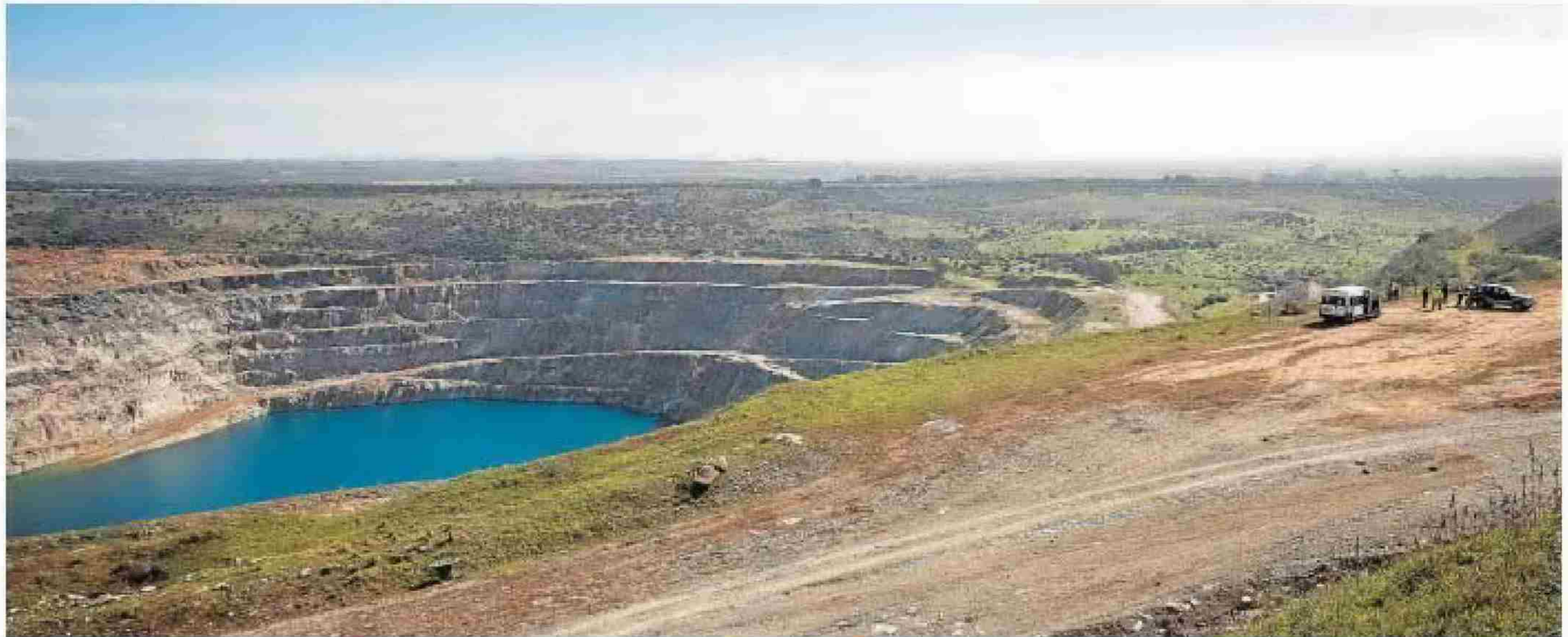
Vista de la corta de los Frailes, en la mina de Aznalcóllar.
