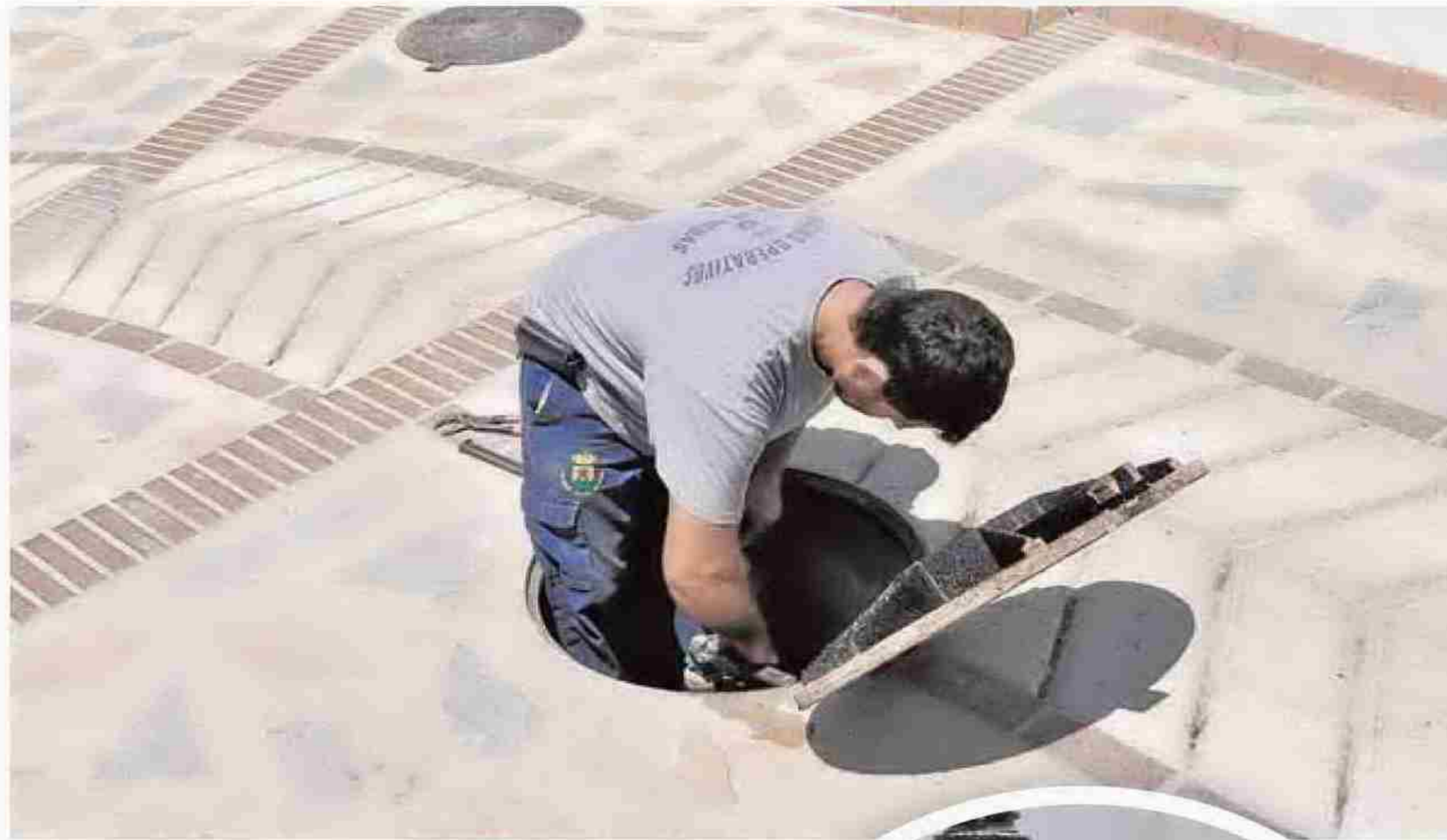
Un fontanero de Arenas corta el agua a una zona de pueblo para que los vecinos de la parte alta puedan tener unas horas de suministro. :: A. P.
