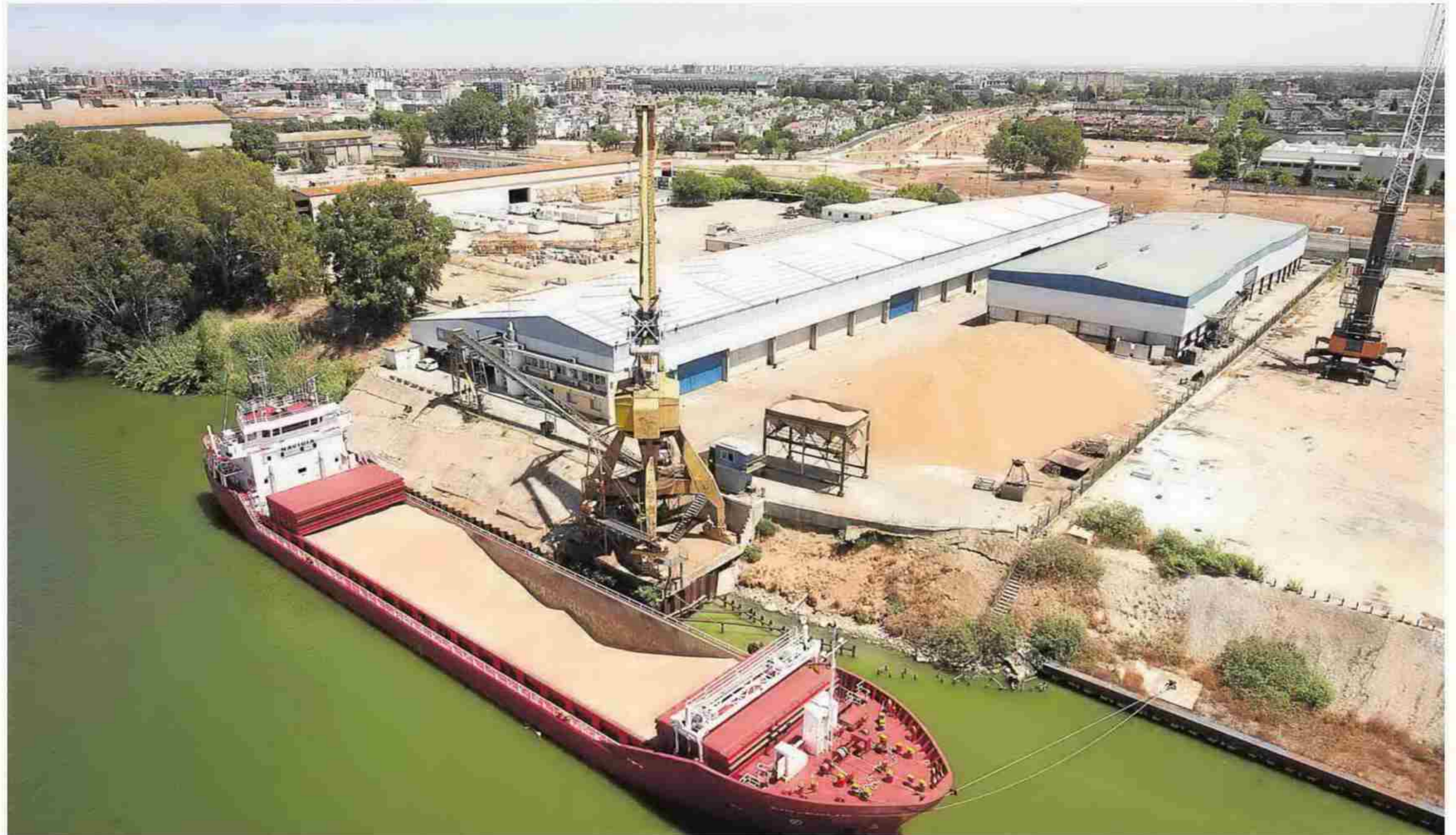
Un buque, durante la carga de mercancía a granel, en las instalaciones del Puerto de Sevilla. / J. M. Paisano
