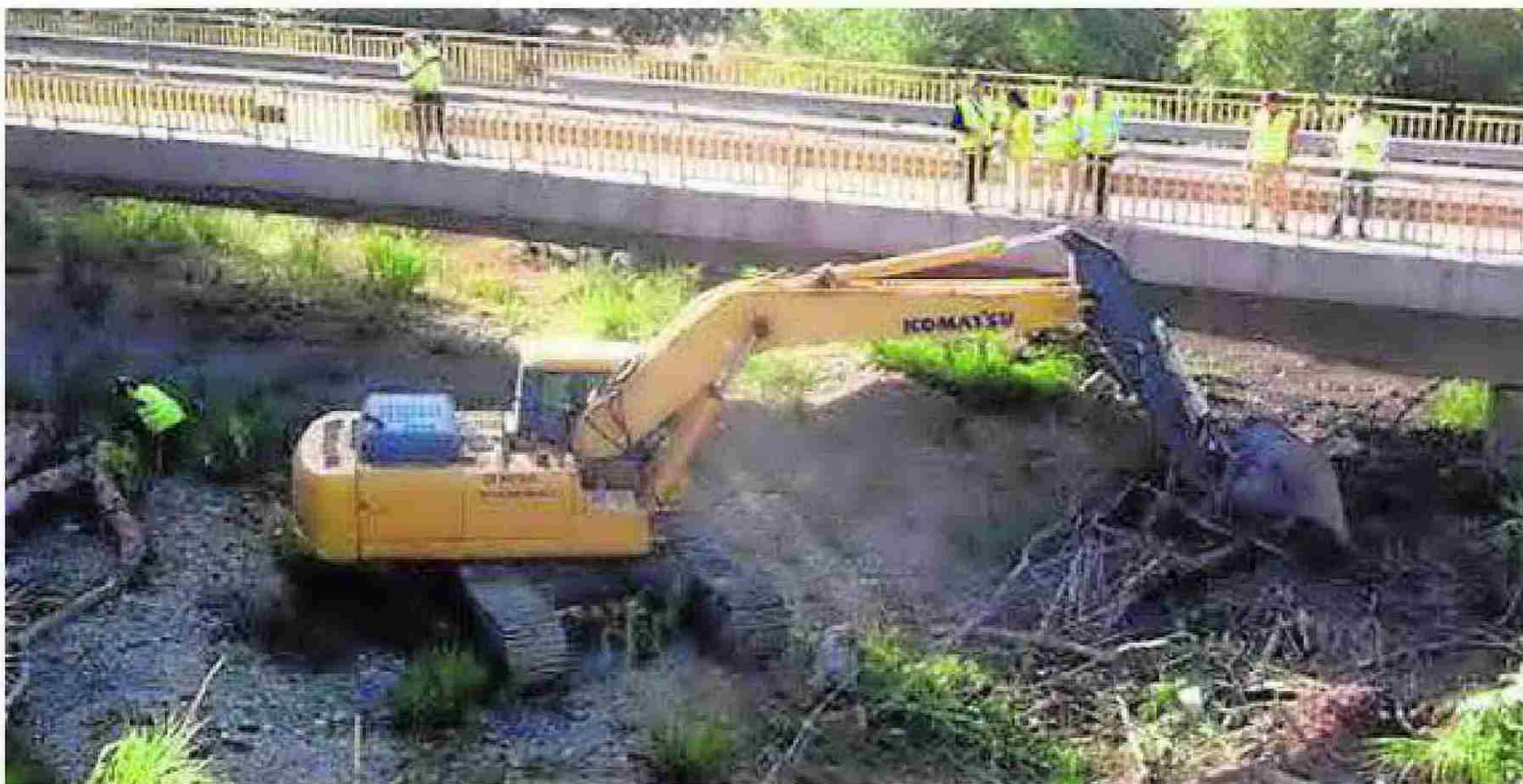
Limpieza del cauce del río Guadalbullón, en las proximidades del Puente Tablas. :: IDEAL
