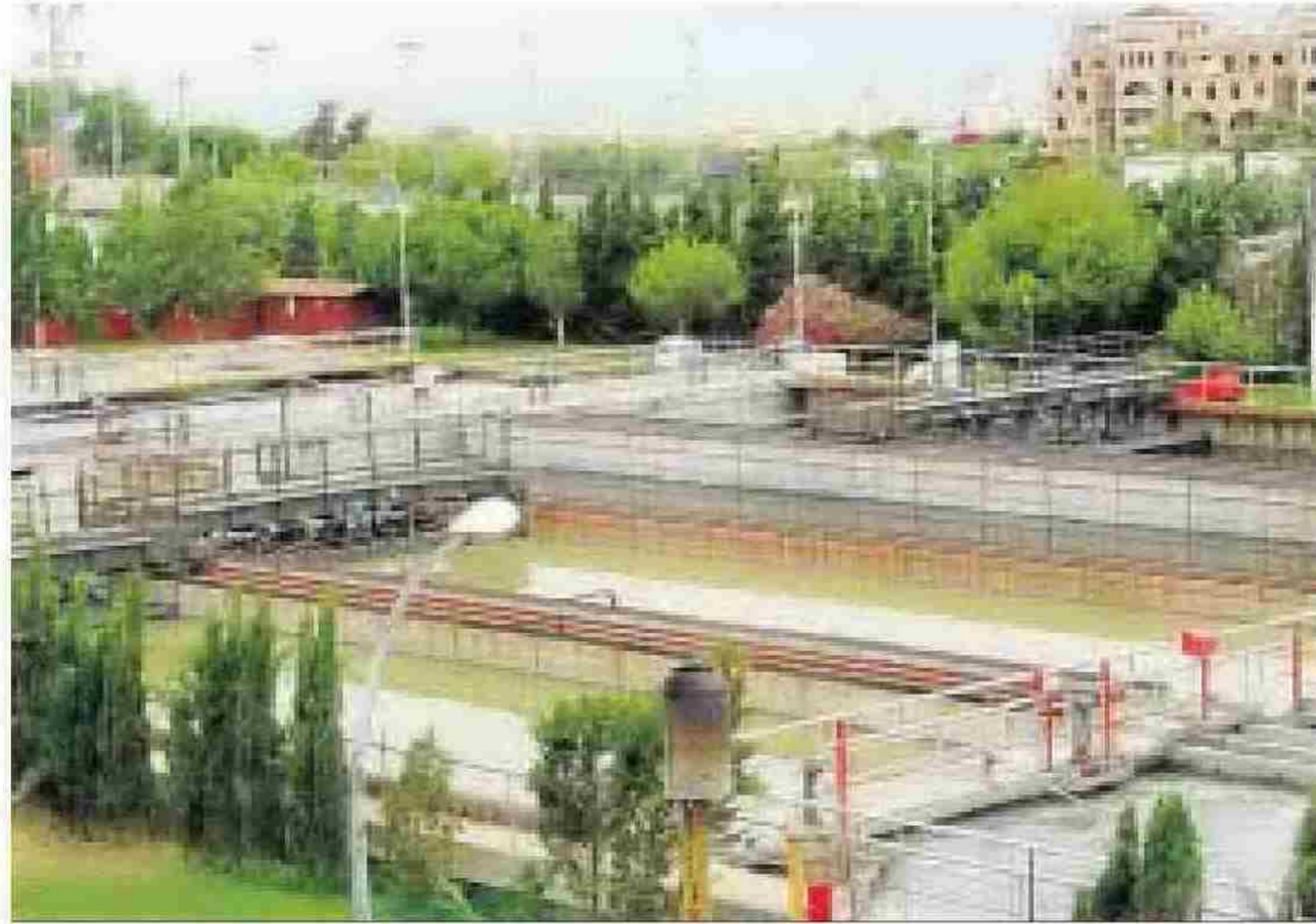
Imagen retrospectiva de la estación depuradora de la ciudad.
