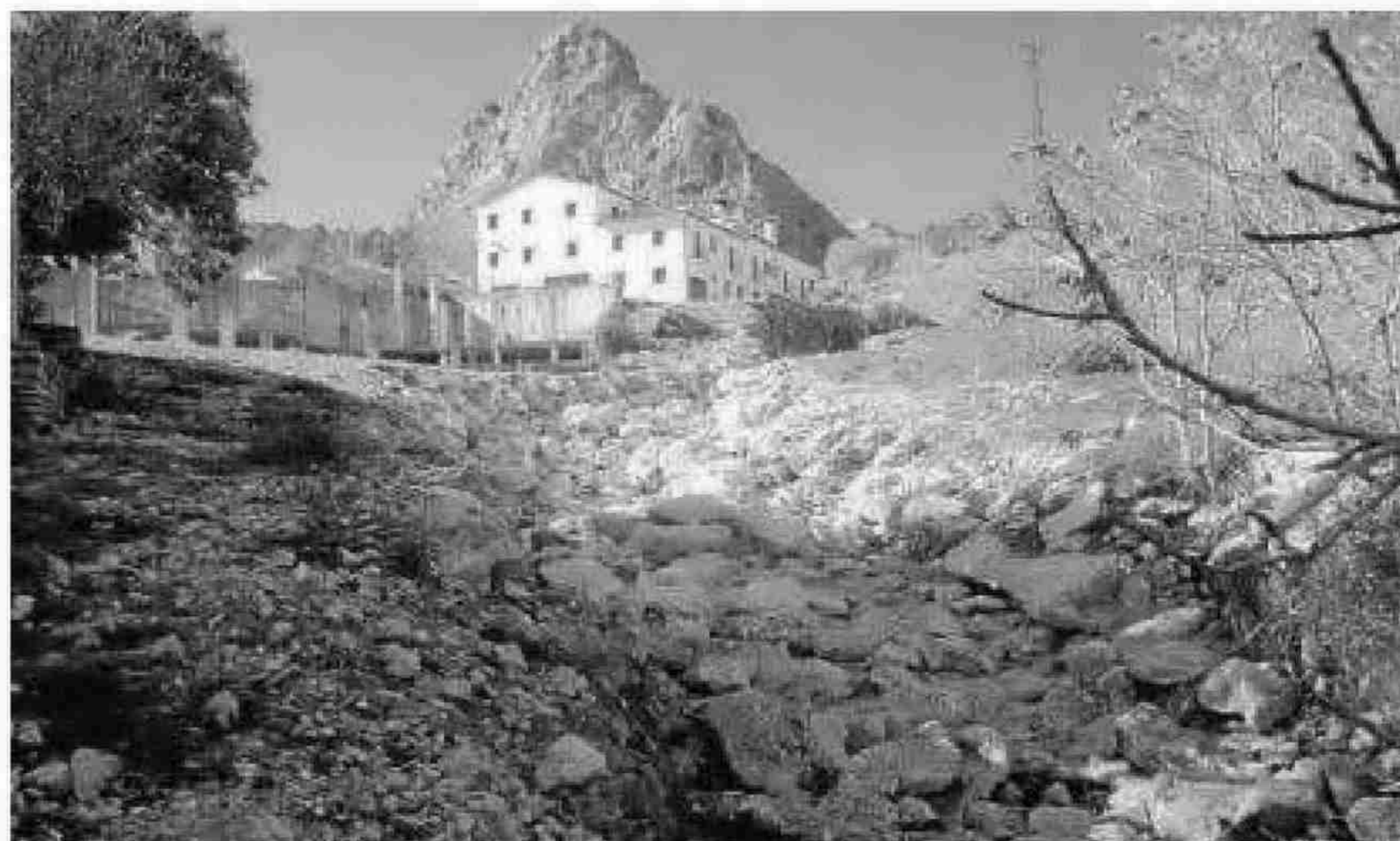
El cauce del Guadalete, tras las obras de restauración, en una fotografía tomada el pasado enero.
