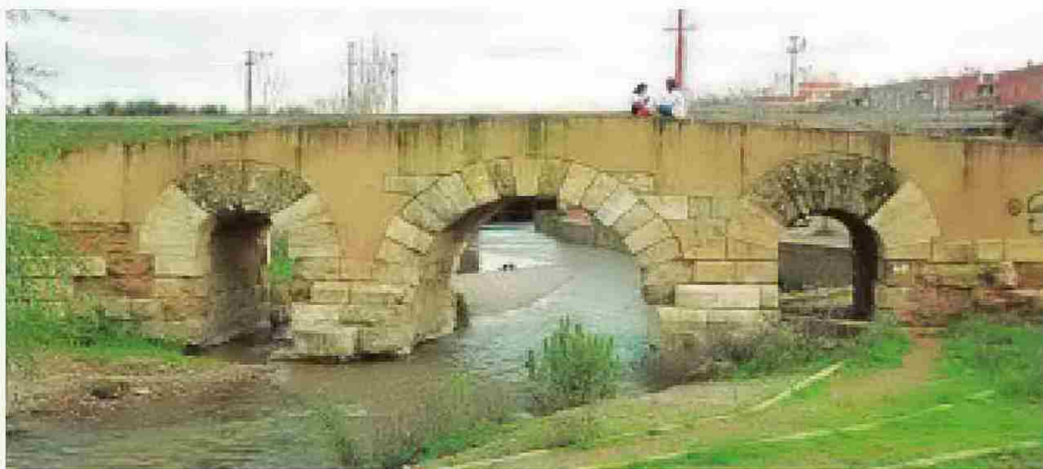
Arroyo Pedroches a su paso por Córdoba
