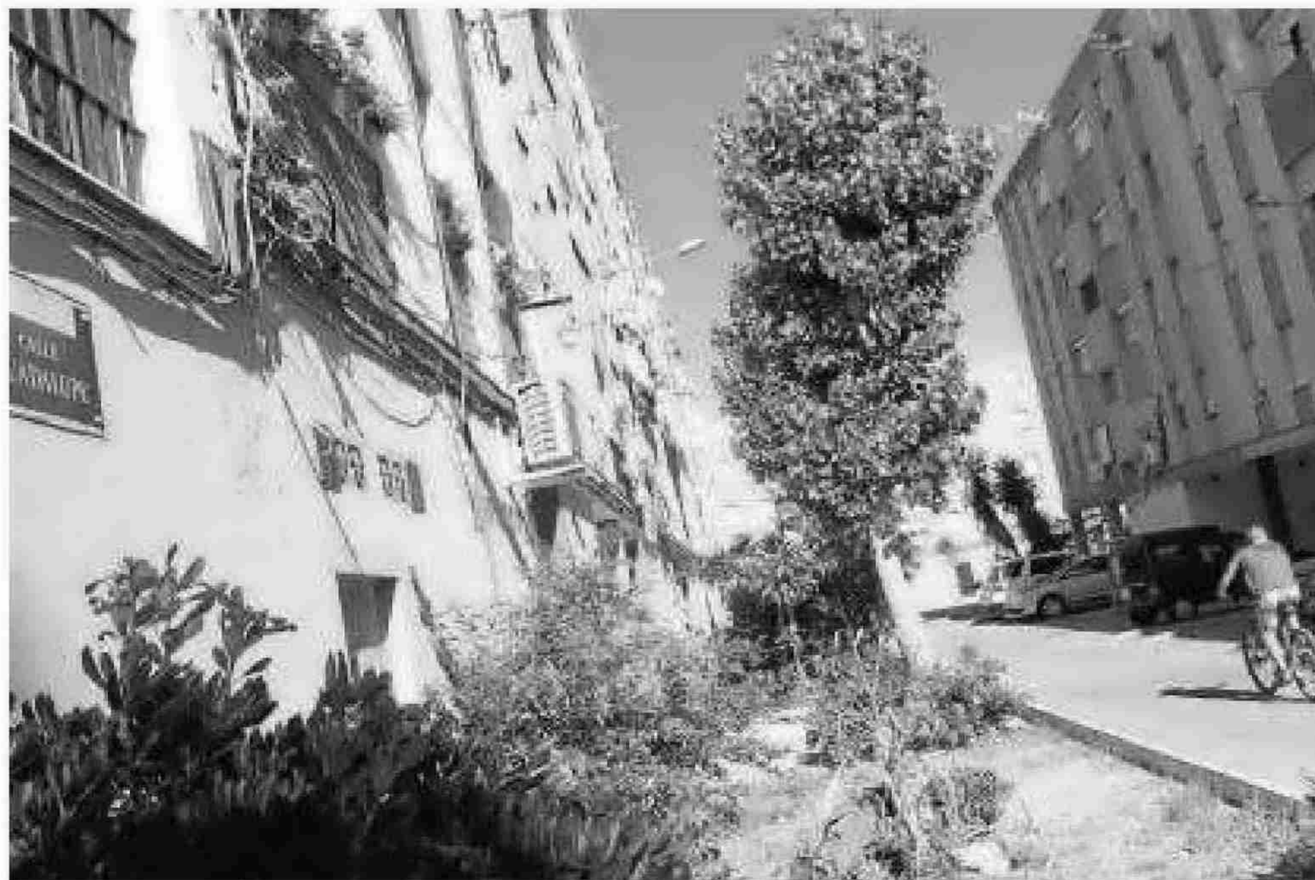
Zona ajardinada de la calle Guadalupe, que se regaba desde los grifos denunciados.
