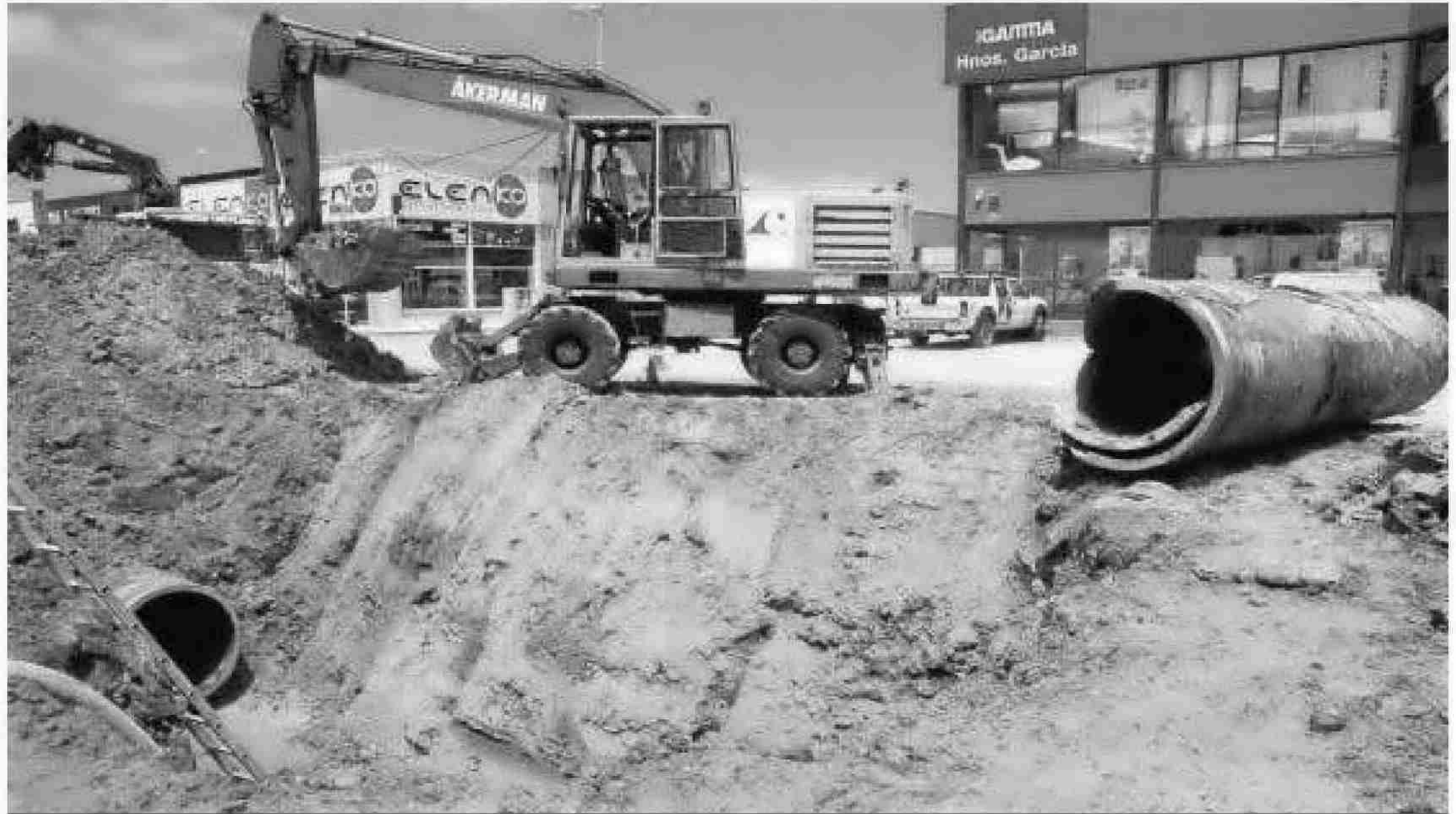
Trabajos, ayer, de reparación de la tubería en San Fernando. A la derecha, el tramo que se rompió el pasado domingo.
