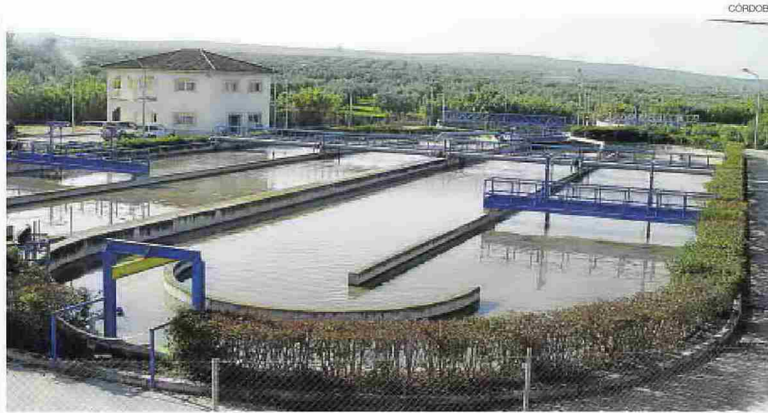
►► Imagen de una de las depuradoras ya construidas en la provincia.
