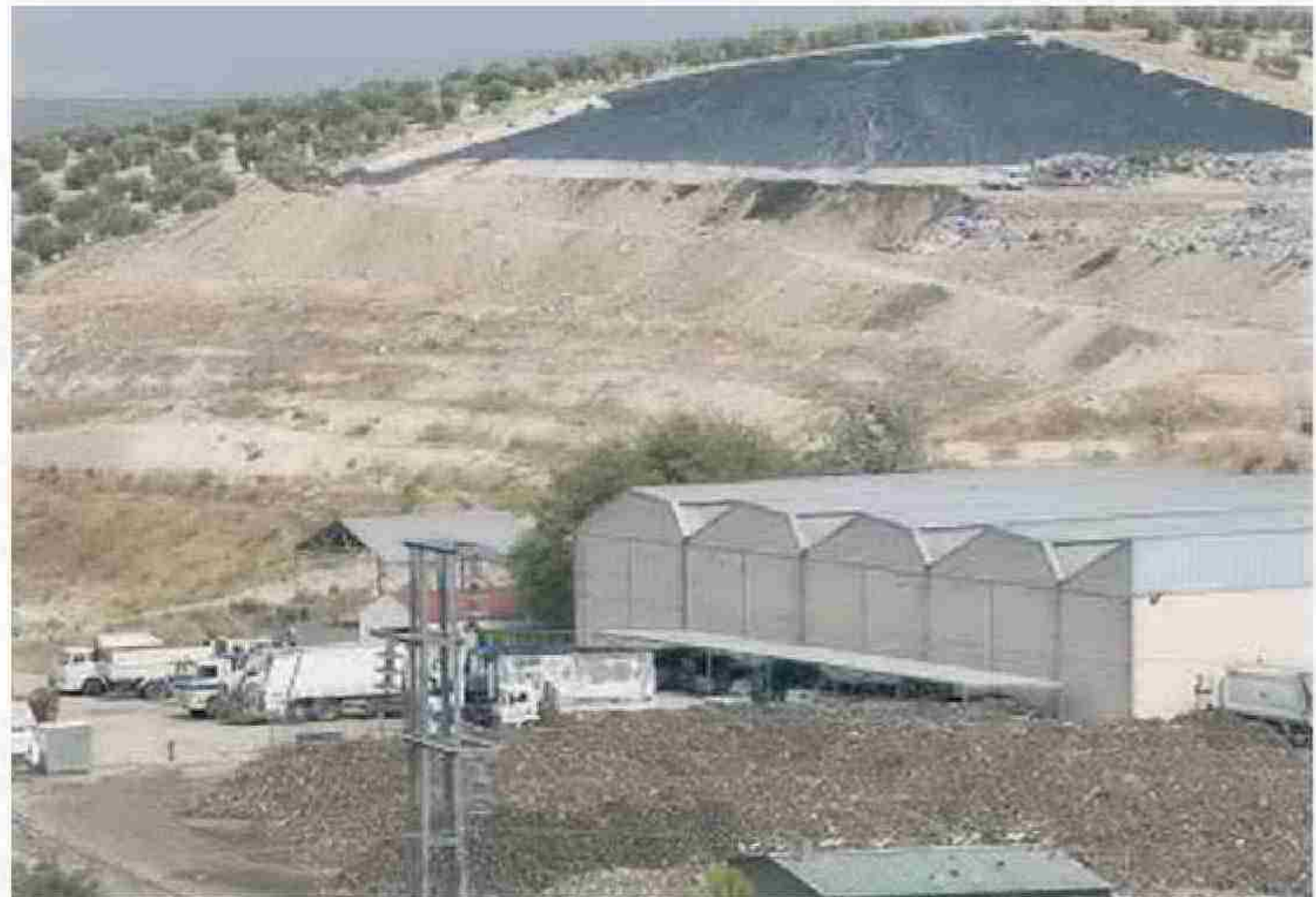
Instalaciones del vertedero de Jaén. VIVA JAÉN
