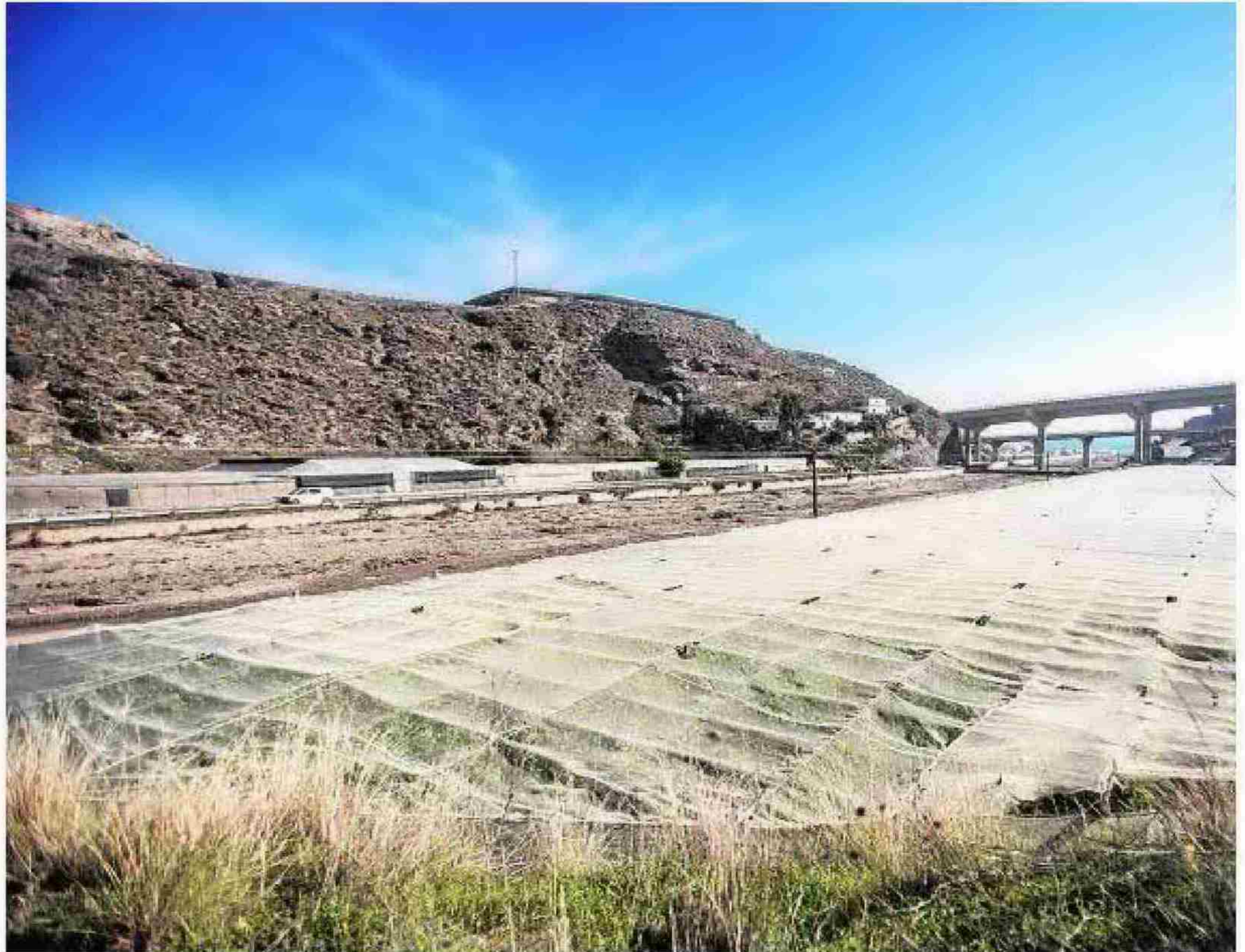
Terrenos sobre los que se construirá la EDAR de Albuñol, que fue adjudicada ayer. :: JAVIER MARTÍN
