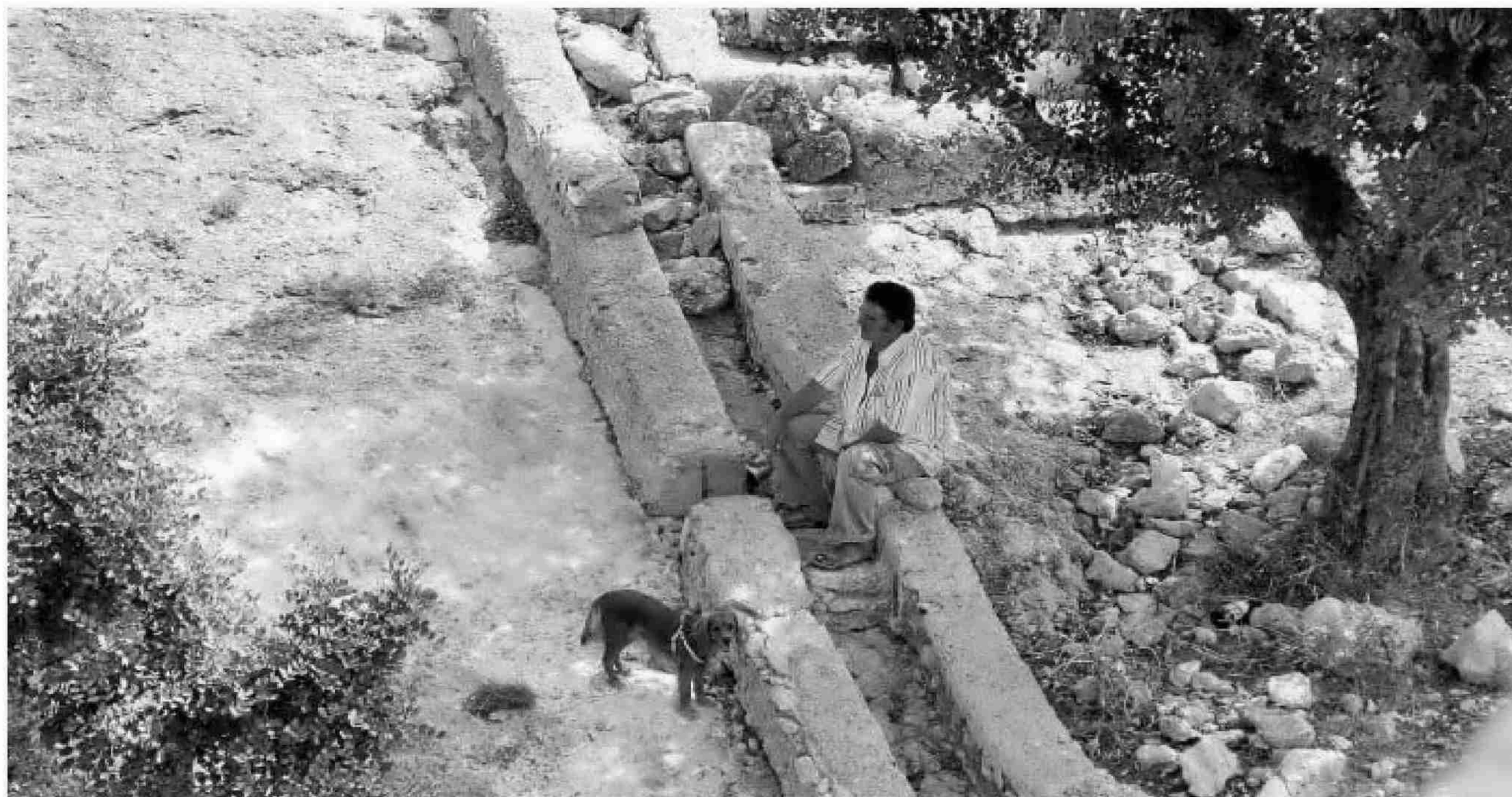
Balsa de los Cien Escalones, ubicada al norte de la capital almeriense, es una de las construcciones que entran dentro de las inscritas en el catálogo.
