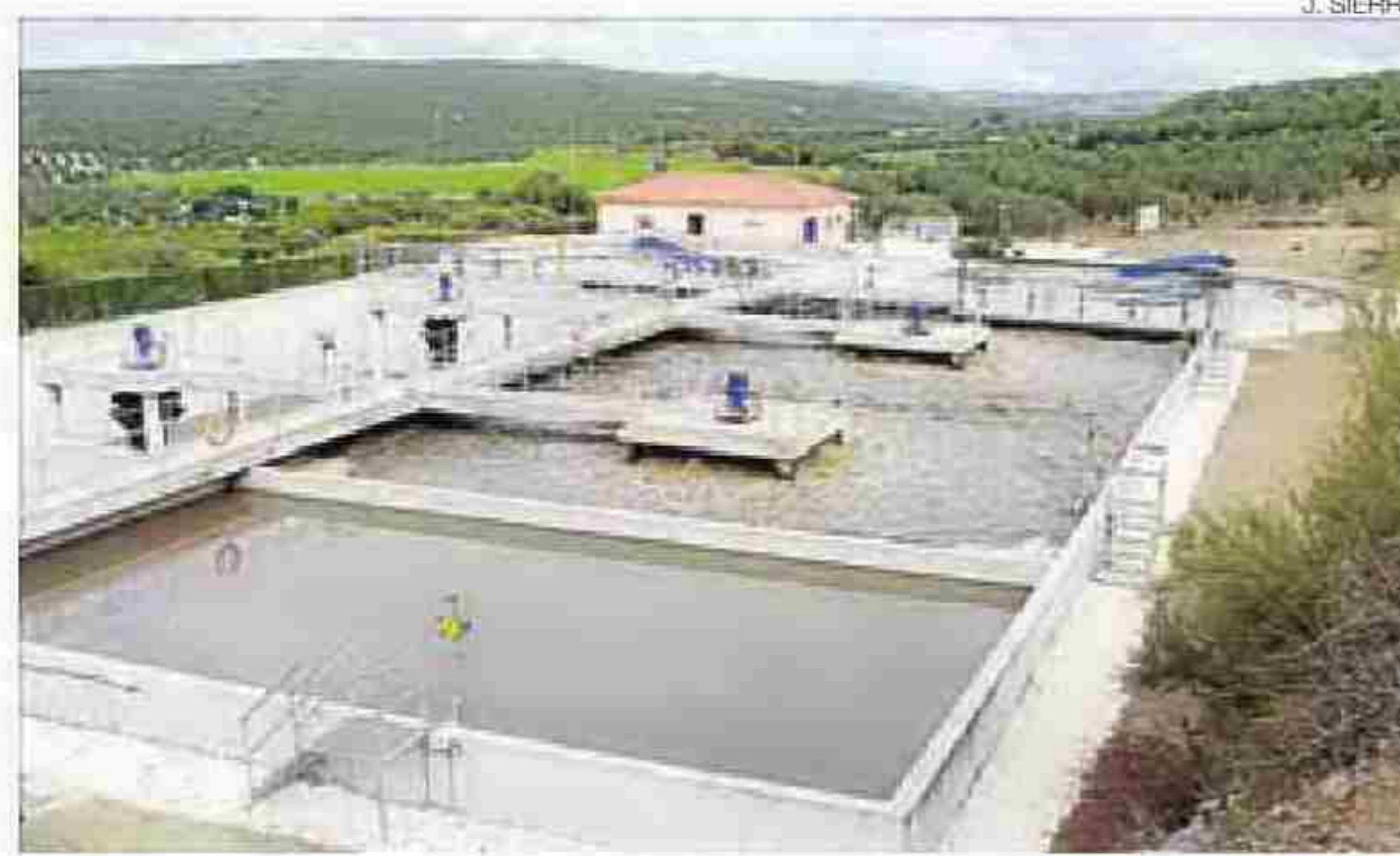
►► Imagen de una depuradora de la provincia.
