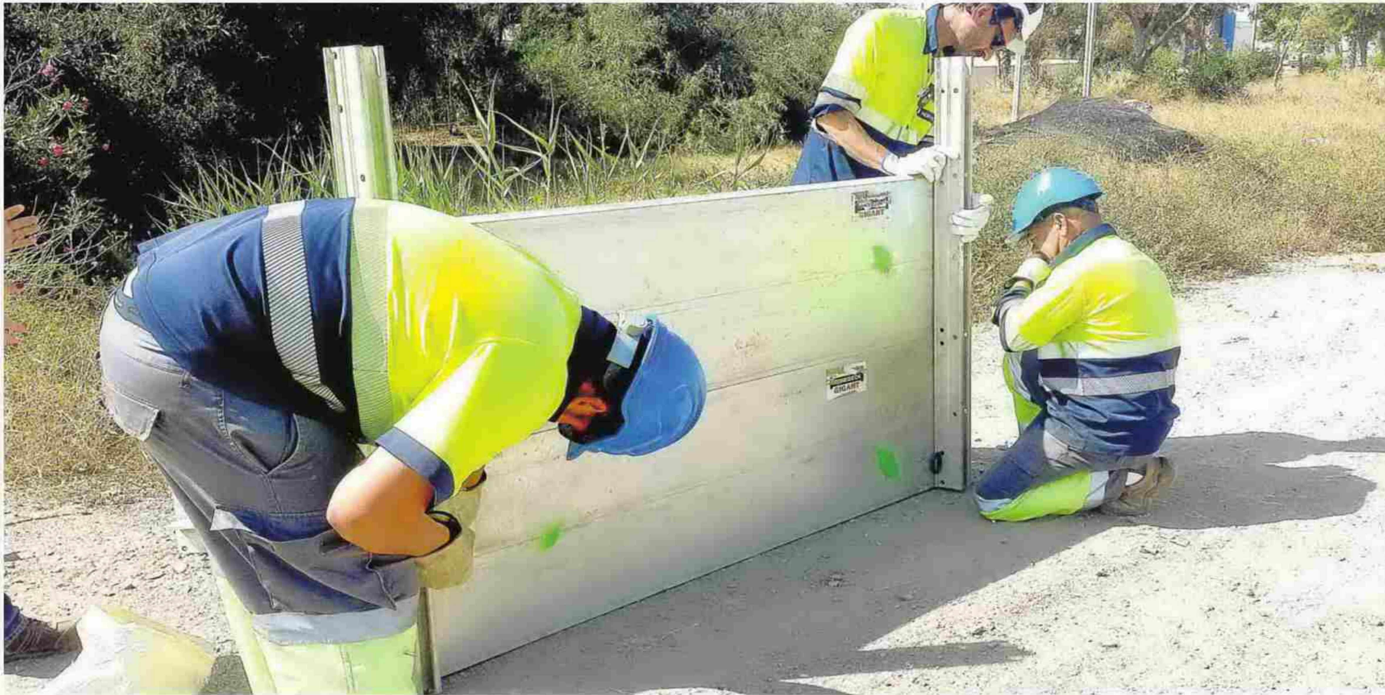
Varios operarios de las empresas de Hidralia participan en un curso de entibaciones desarrollado en Almería. / El Correo
