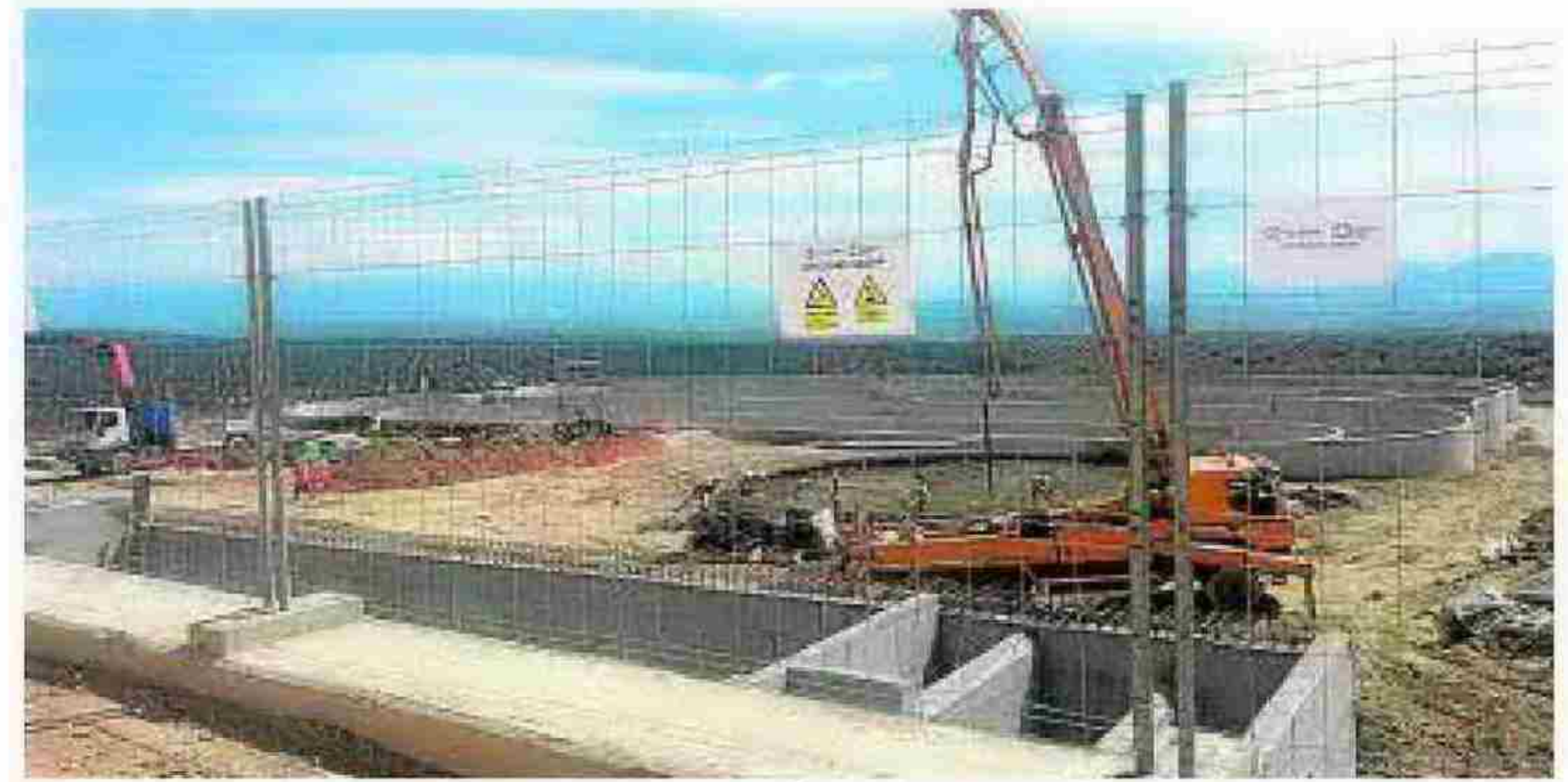
Construcción de la depuradora de Úbeda. :: IDEAL
