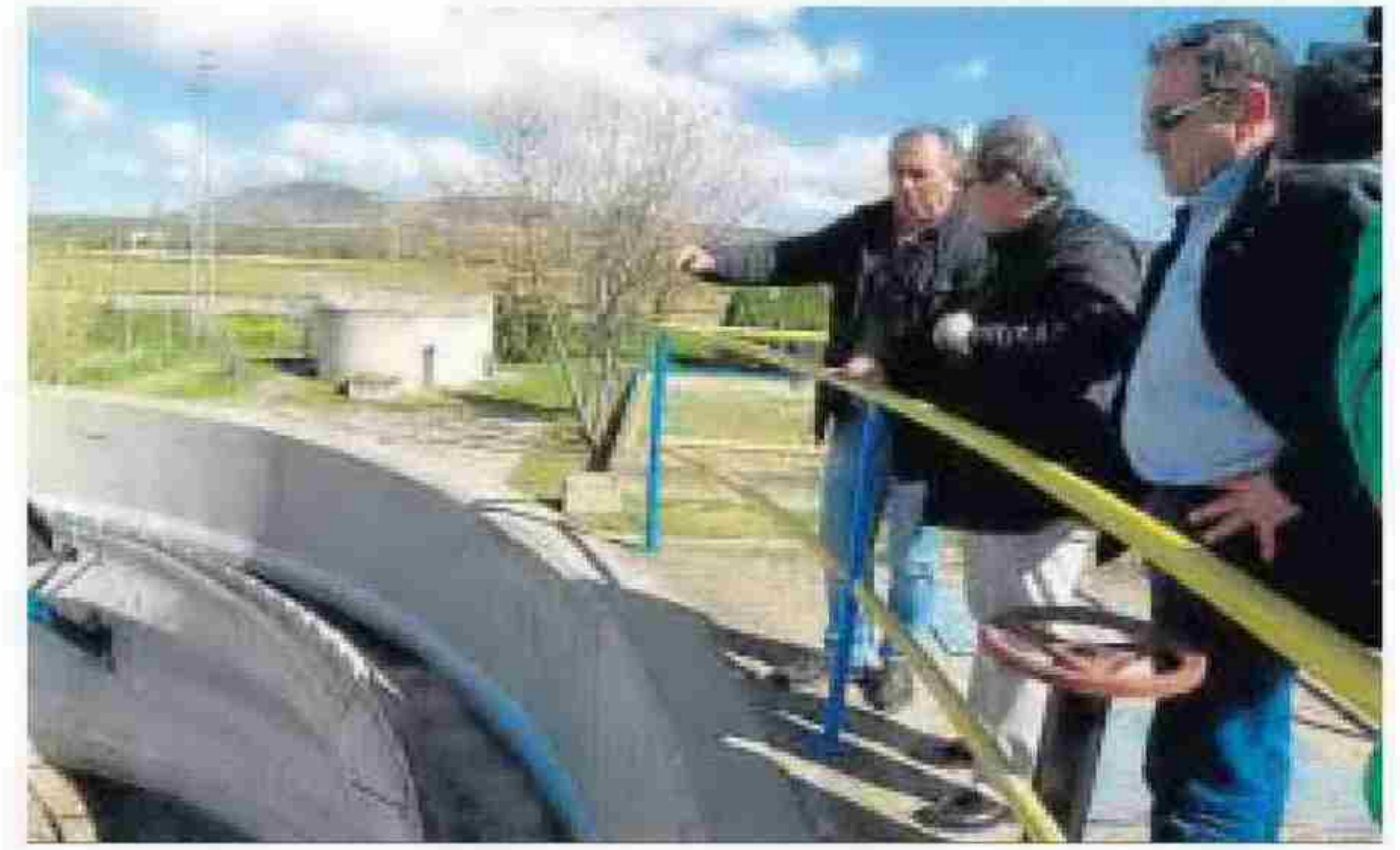
El alcalde y el concejal de Infraestructuras visitando el miércoles la EDAR.
