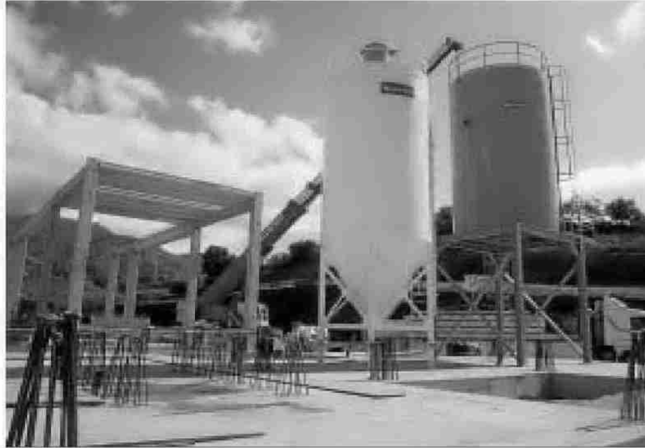
Obras en la depuradora de Nerja.
