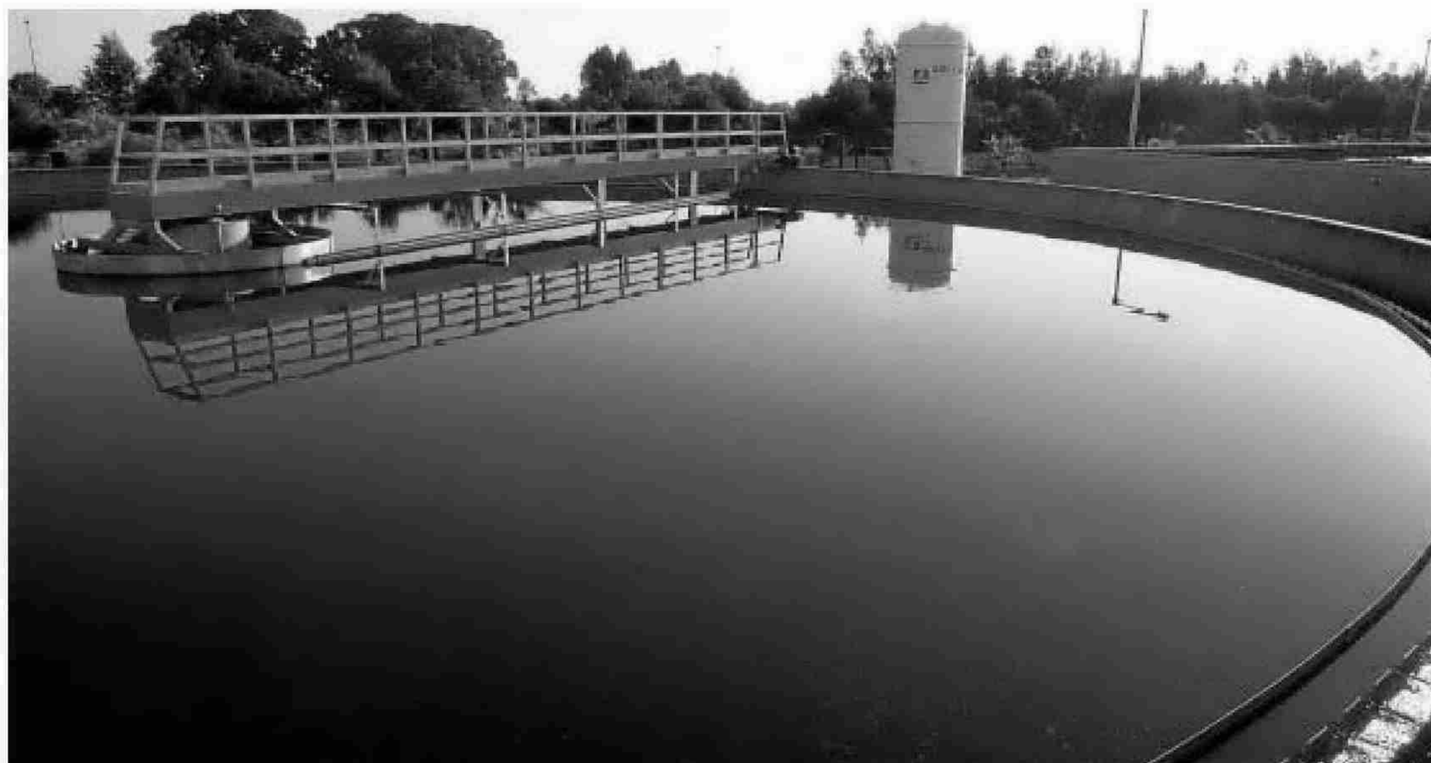
Estación depuradora de aguas residuales de Ayamonte.
