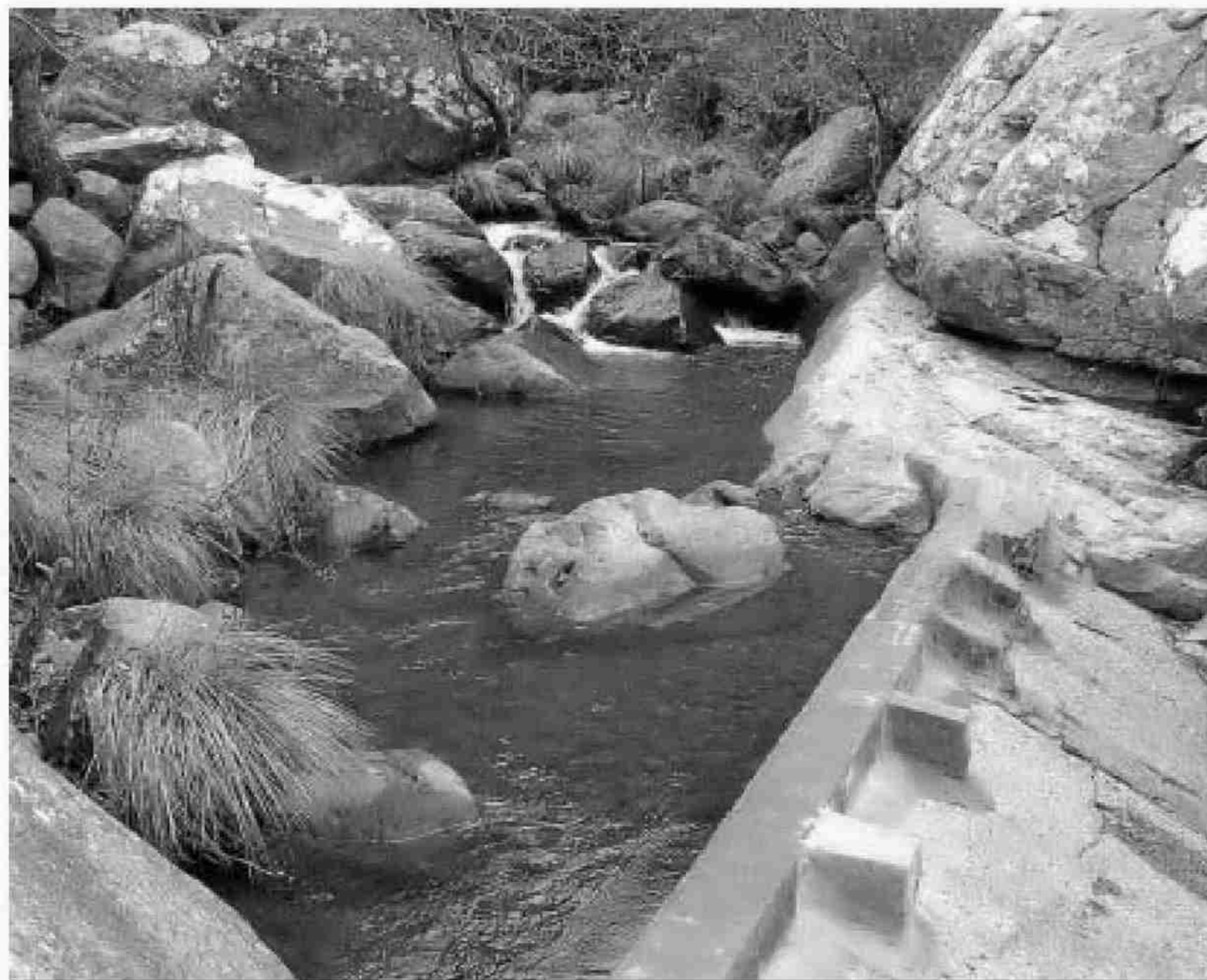
Imagen de archivo de la presa que sirve para captar agua en la zona de la Garganta del Capitán.
