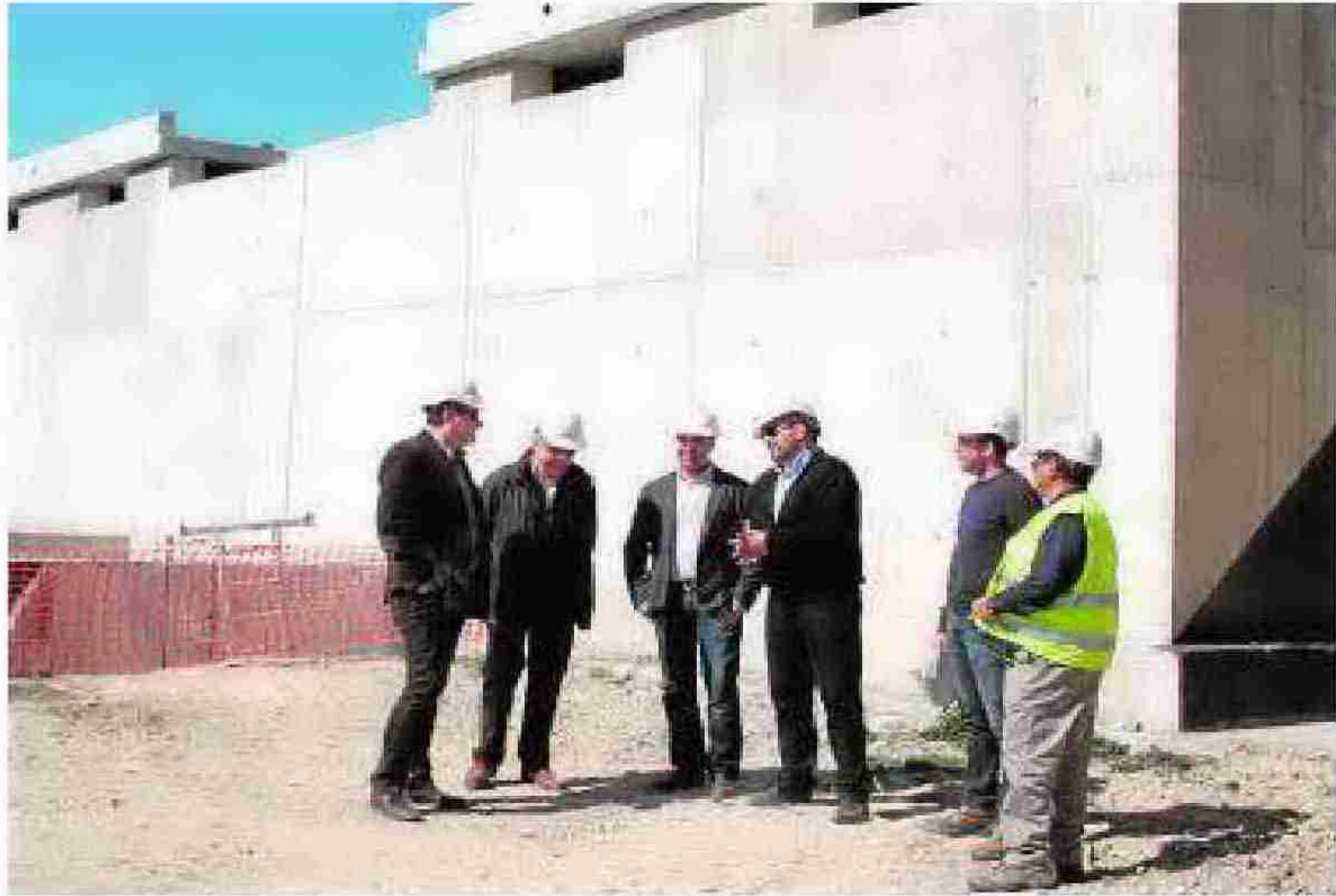
Visita al depósito que se está construyendo. :: s. c.
