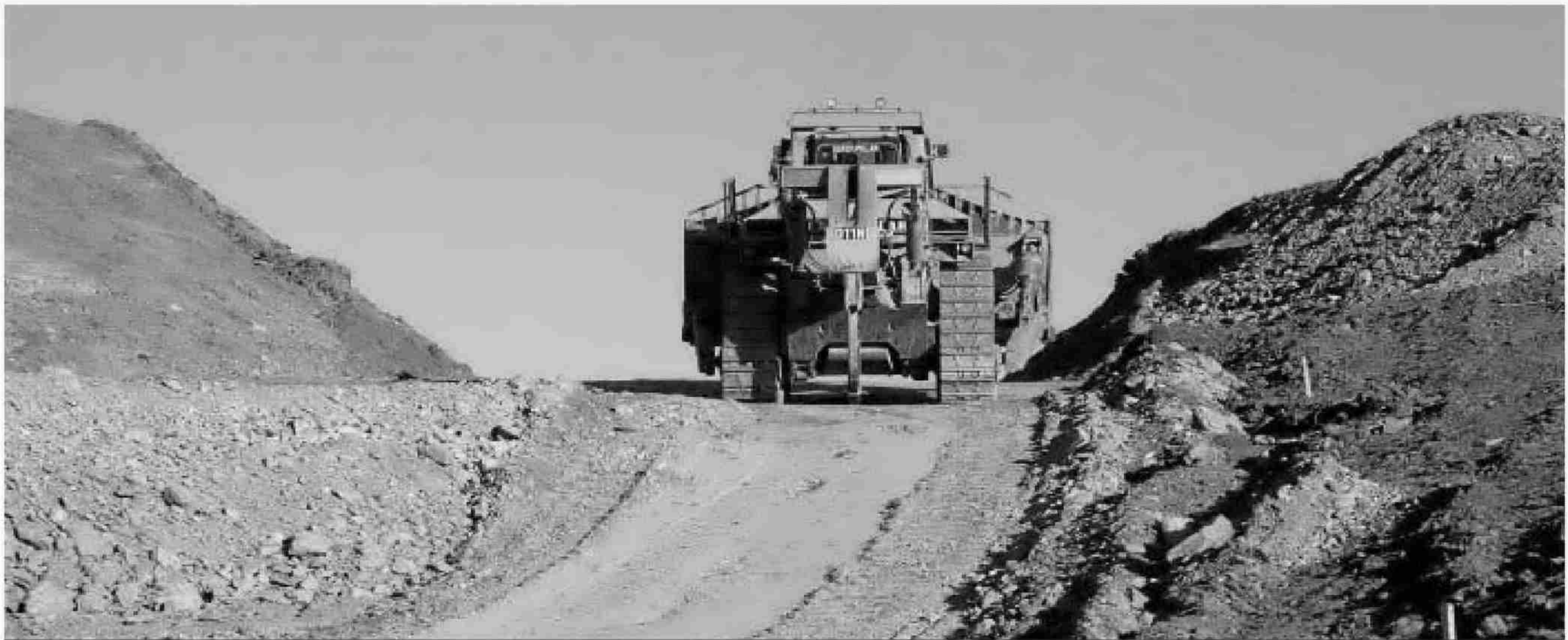
Diversa maquinaria trabaja ya en la zona de construcción de la presa de Alcolea.
