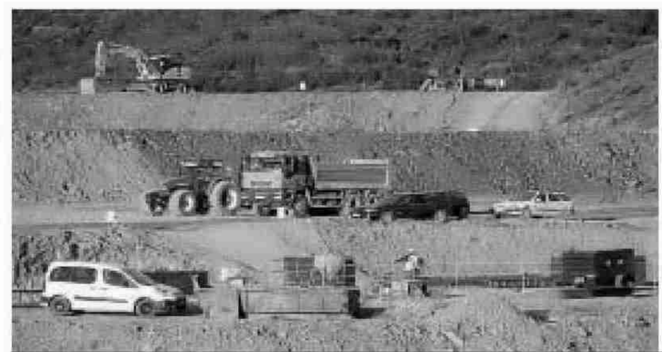
Las obras dieron comienzo en 2012 con la carretera de acceso.
