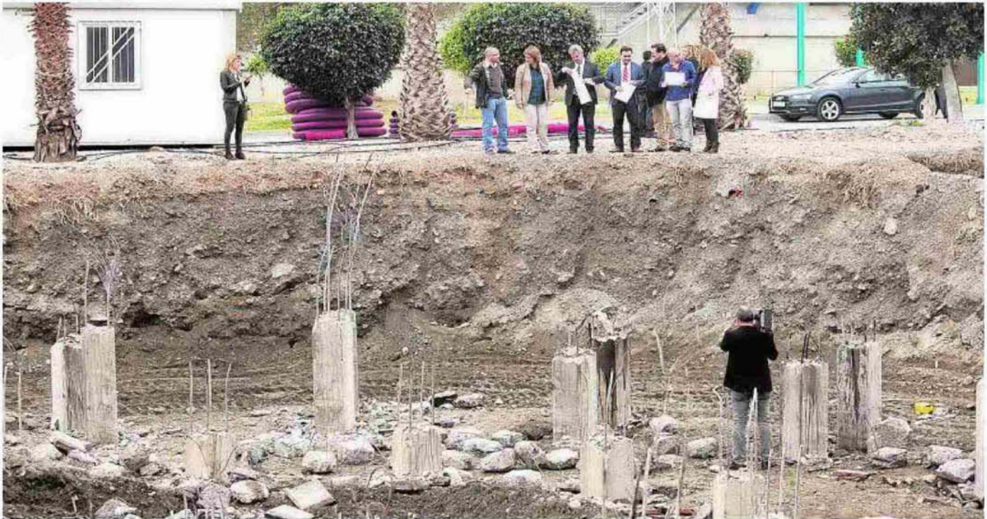
García Chamorro, García Fuentes y Fernández Pulido observan las obras de la depuradora. :: JAVIER MARTÍN
