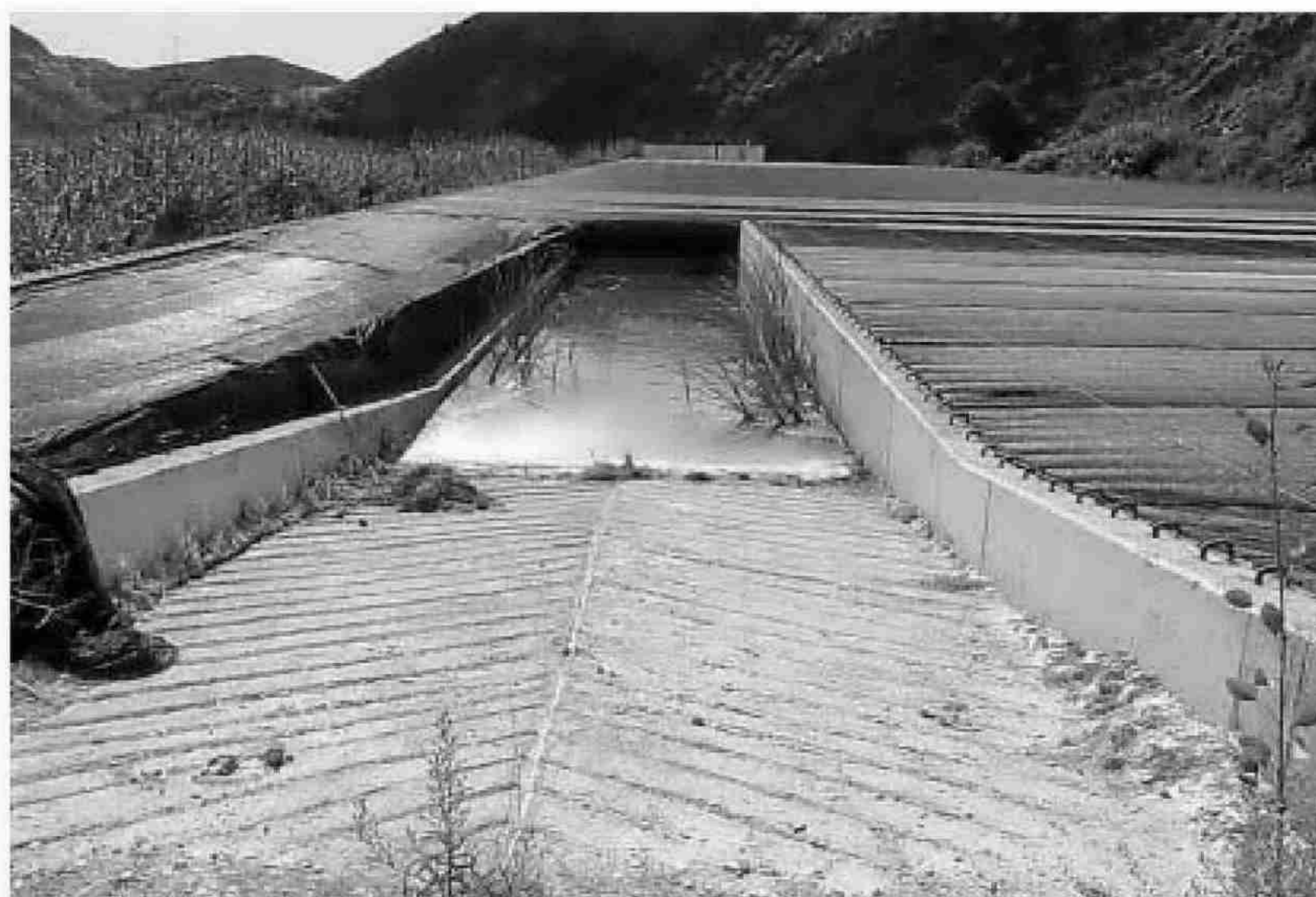
Depósito donde se acumula el agua con la que se suministra a los regantes de la comunidad
