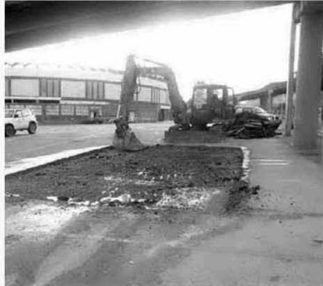
Trabajos en los aledaños de la plaza de Toros de Algeciras. VIVA CG
