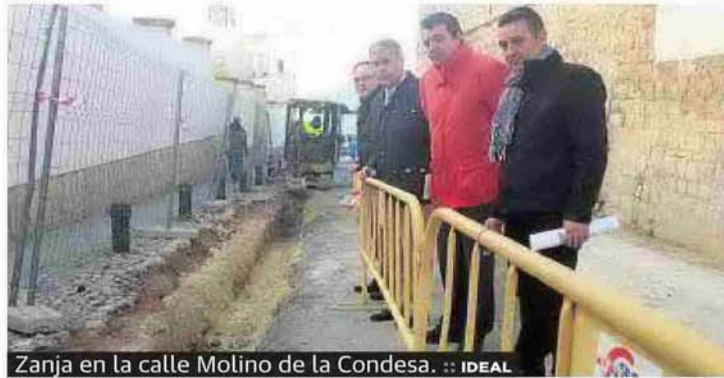
Zanja en la calle Molino de la Condesa. :: IDEAL
