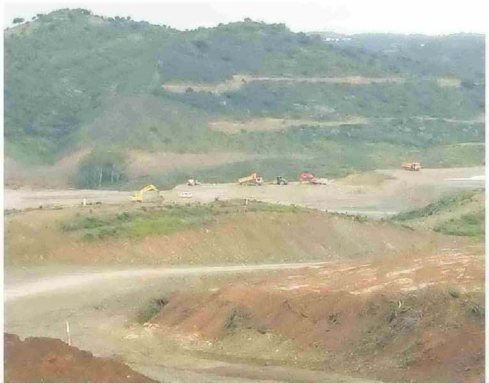
Obras en marcha. VH
