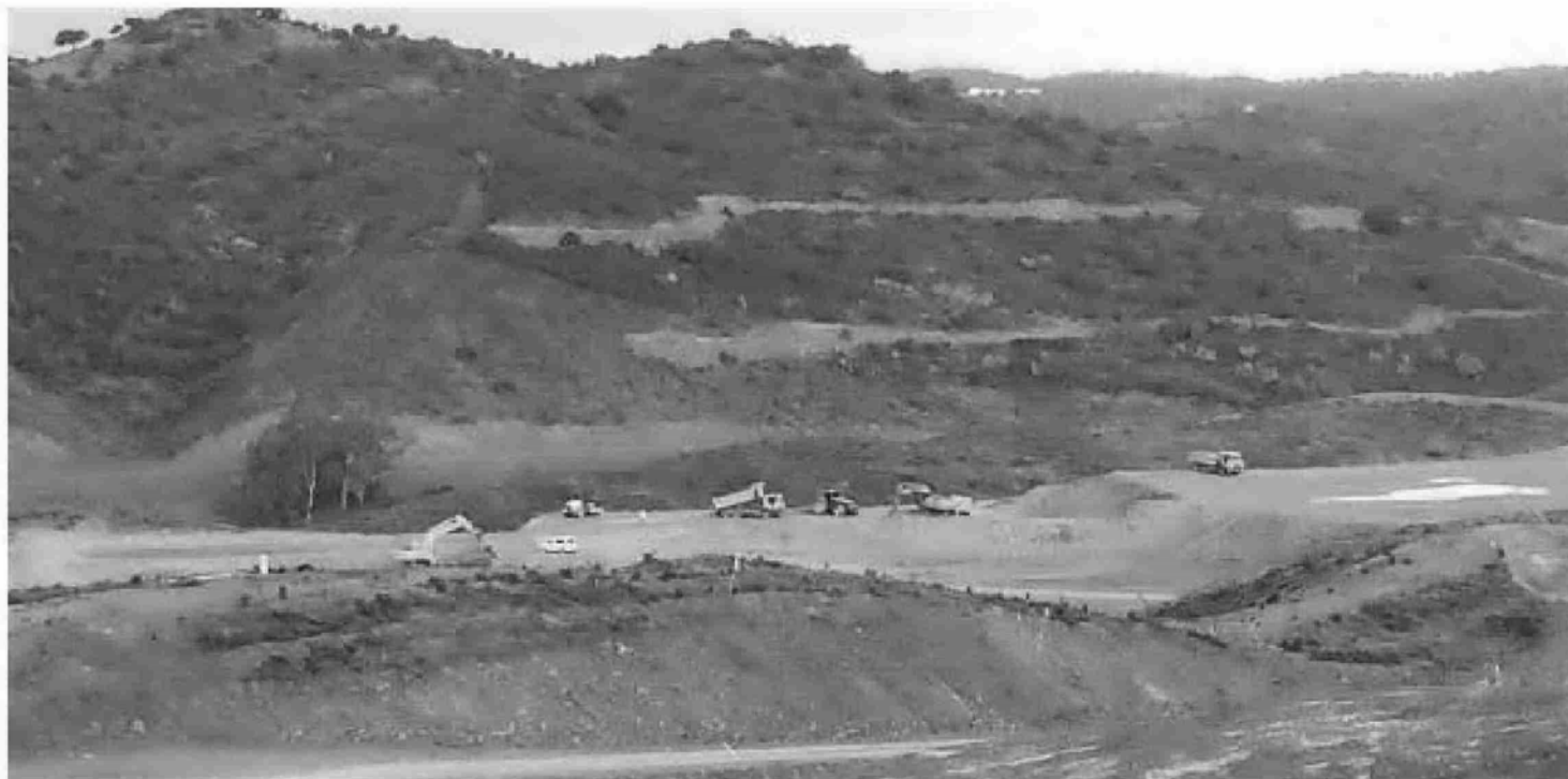
Camiones y excavadoras trabajan en la construcción del cuerpo del embalse.
