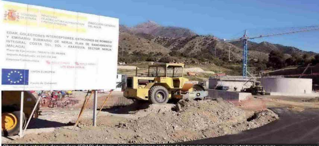
Obras de la estación depuradora (EDAR) de Nerja, único municipios costero de la provincia que sigue sin tratar sus aguas. :: EUGENIO CABEZAS
