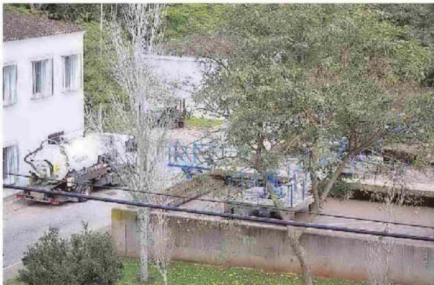
Parte de la instalación de la Estación Depuradora de Arcos. :: A. R.
