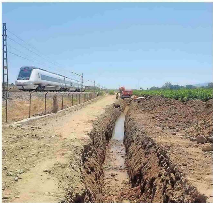
Creación de las canalizaciones por las que transitarán las aguas del Bajo Guadalhorce. :: SUR
