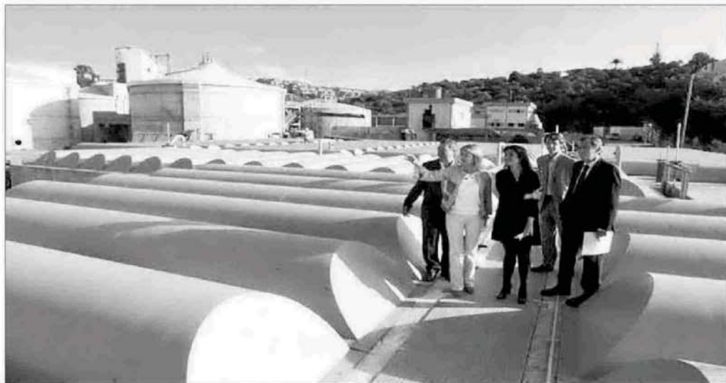
Ángeles Muñoz y Margarita del Cid, durante una visita a las obras de la depuradora de La Víbora. L. O.
