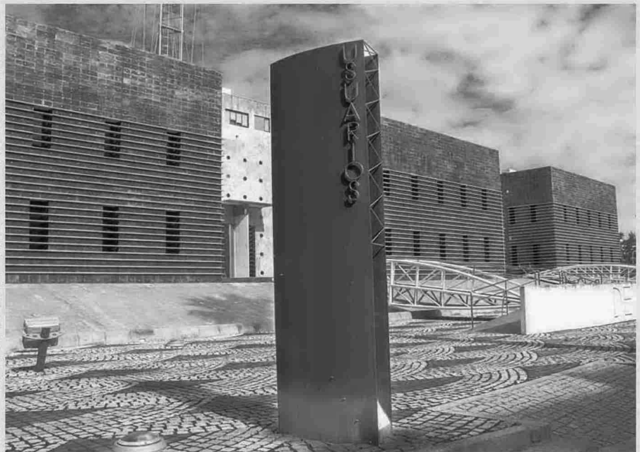
La atención al usuario ocupa un lugar principal en la gestión de Aguas de Huelva. VH
