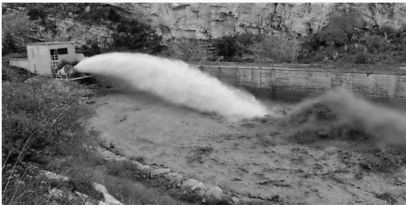
El pasado mes de diciembre la Junta llevó a cabo la apertura de desagües del fondo de la presa como maniobra de mantenimiento.
