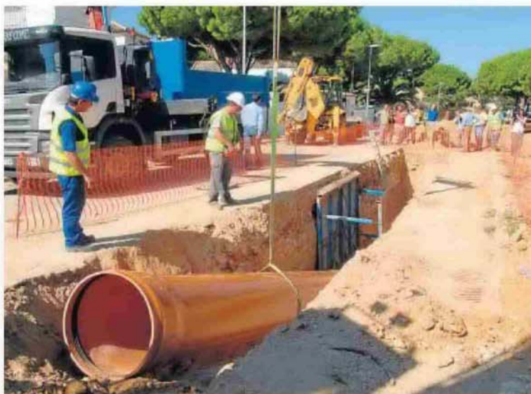
Imagen de archivo de la instalación de tubos en una calle de la ciudad.
