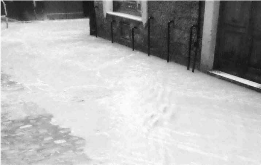
La calle San Juan quedó completamente anegada el pasado domingo ya que las alcantarillas no daban a basto. G. F.
