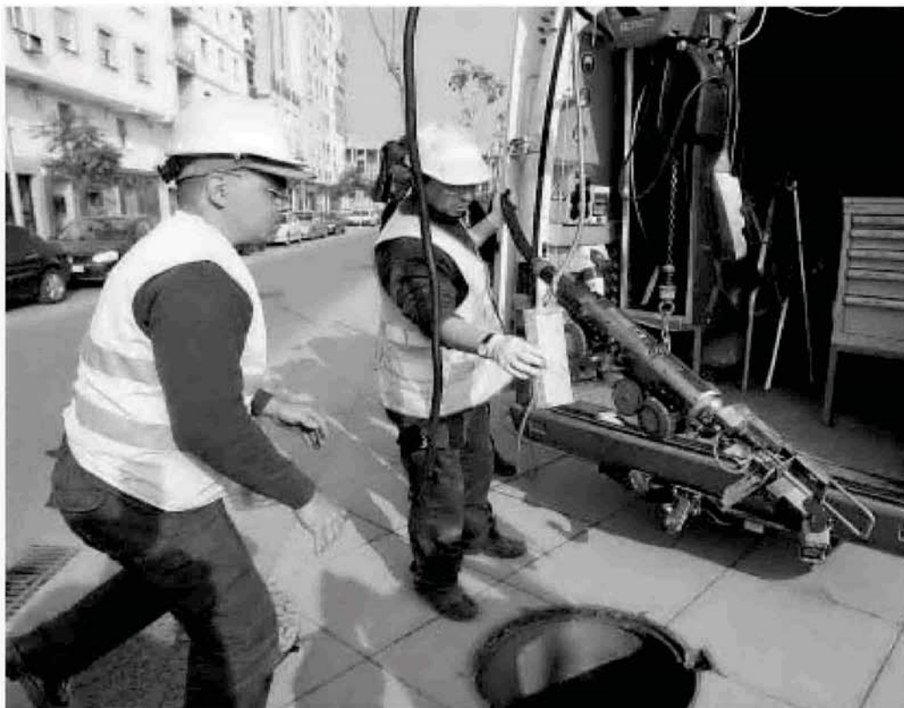
Unos operarios trabajan en la mejora de un alcantarillado.
