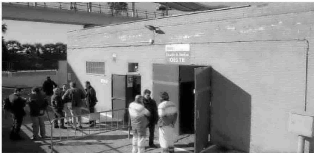
Estación de bombeo de Pery Junquera.
