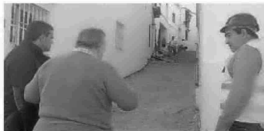
El alcalde, José Ortiz ha conocido sobre el terreno el desarrollo de las obras.
