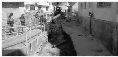
OBRAS en Rambla de las Cruces para evitar inundaciones.
