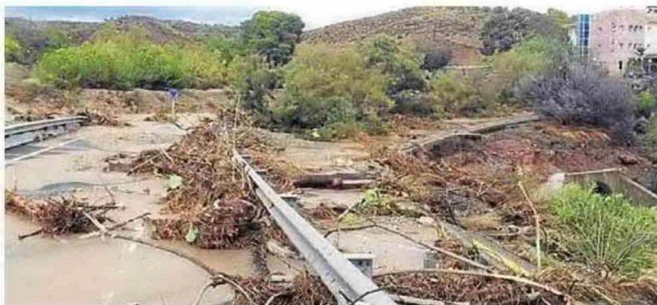
LAS LLUVIAS produjeron importantes daños en infraestructuras y carreteras. LA VOZ
