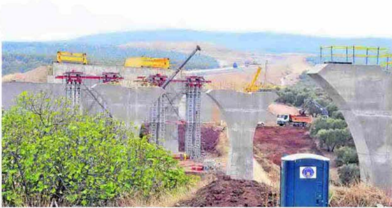
Tramo de la A-32 a su paso por el término de Linares. :: ENRIQUE
