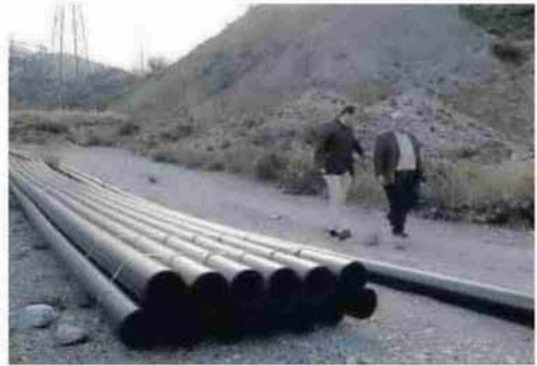
José Robles visitó las obras.
