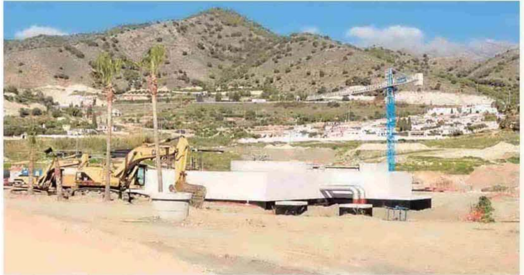
Sobre la parcela de Aguahierro ya son visibles los primeros depósitos y tuberías de depuración. :: e. c.
