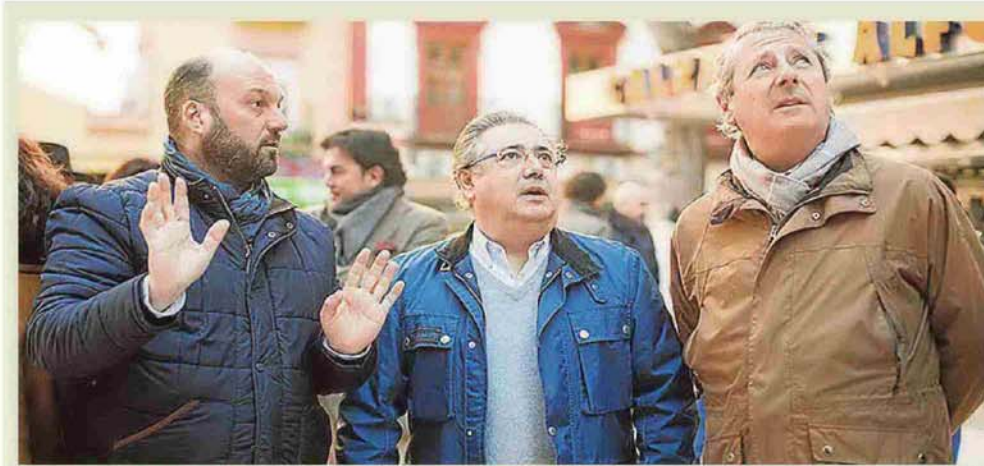
Obras en la calle Peñaflo. El alcalde de Sevilla, Juan Ignacio Zoido, visitó las obras de remodelación de la calle Peñaflo, acompañado del delegado del Distrito Triana, Curro Pérez, y del consejero delegado de Emasesa, Jesús Maza. Los trabajos consisten en la renovación del alcantarillado y la reurbanización de la vía.
