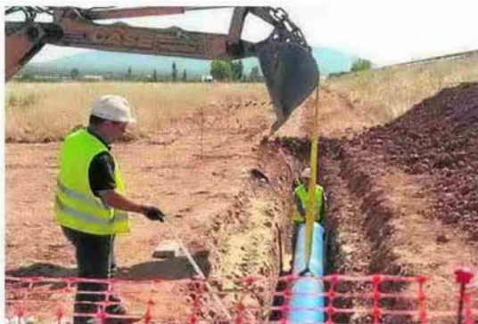
Instalación de las nuevas conducciones en El Condado. :: IDEAL
