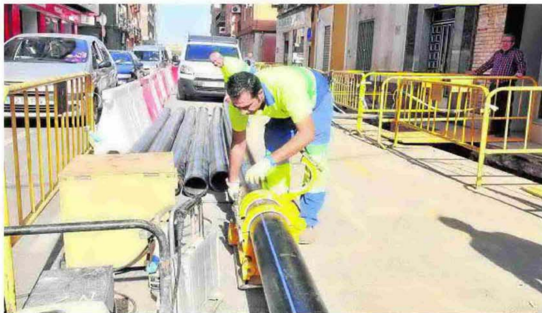
El Ayuntamiento prevé desarrollar la sustitución de la red en los próximos meses. :: ENRIQUE
