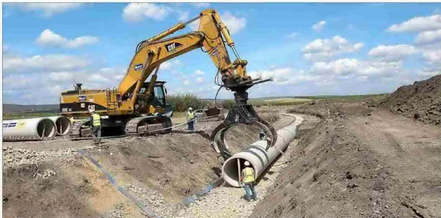
Obras de colocación de la tubería para conducir hasta Sevilla el agua del pantano de Los Melonares, el pasado mes de marzo. ESTHER LOBATO
