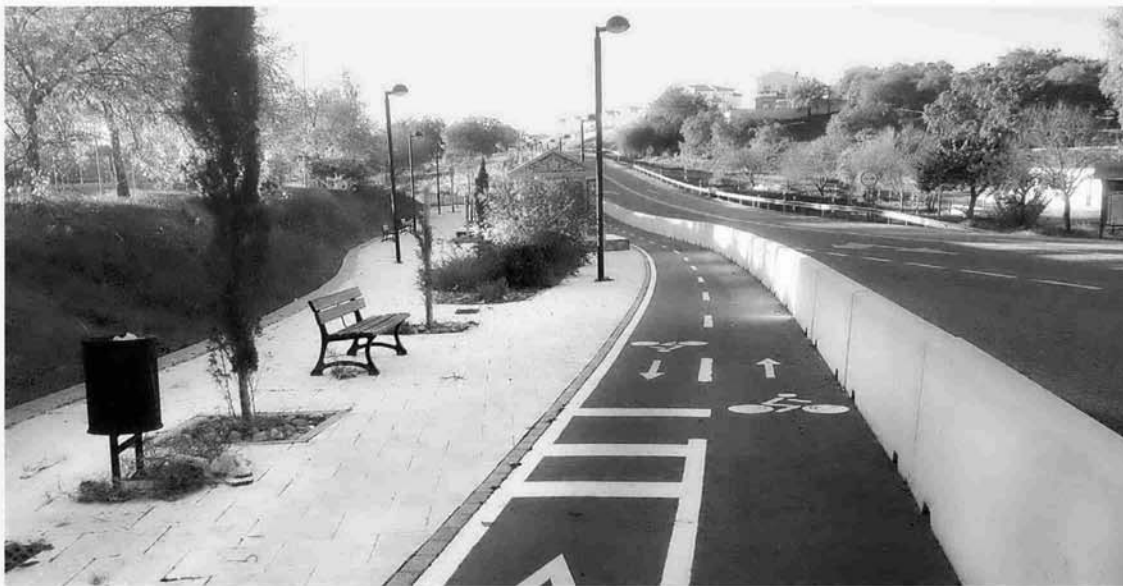
Construcción de carriles bici en los entornos urbanos y en los accesos a los polígonos industriales. / Diputación
